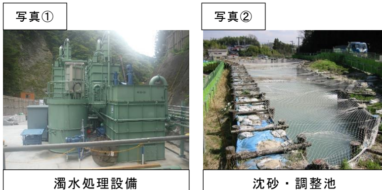
図3-4-2-1 水環境に関する計画面の環境保全措置（写真は類似工事の例）
