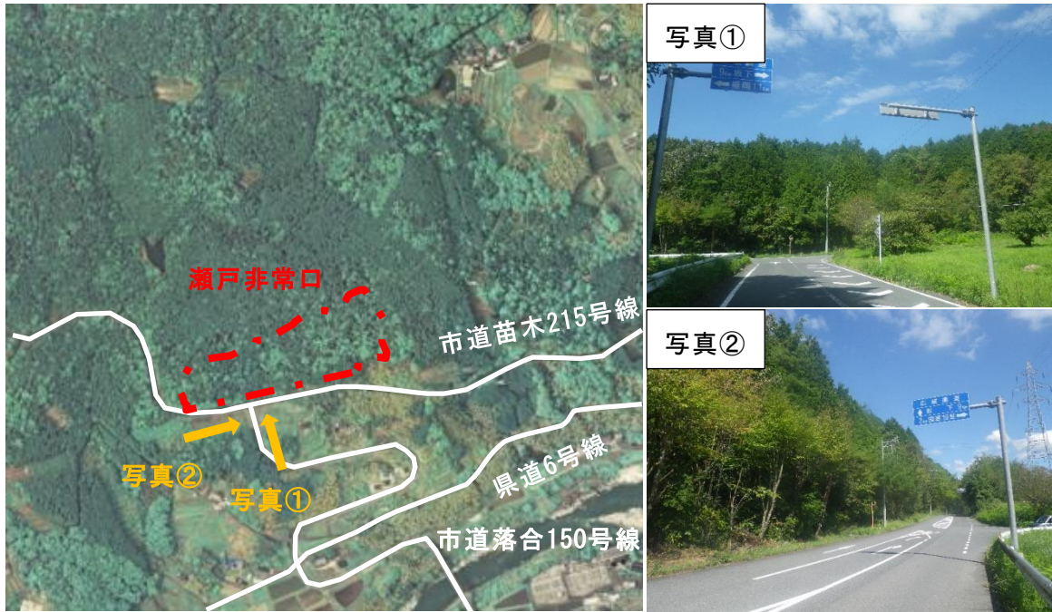
図 2-2-3 瀬戸非常口の工事前の状況
