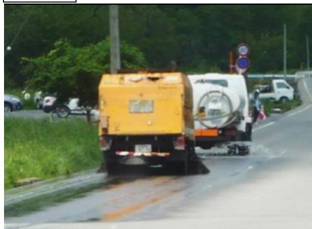
道路の散水・清掃状況
