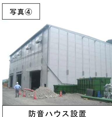
図3-4-1-1 工事施工ヤードにおける大気環境に関する計画の環境保全措置 (写真は類似工事の例)
