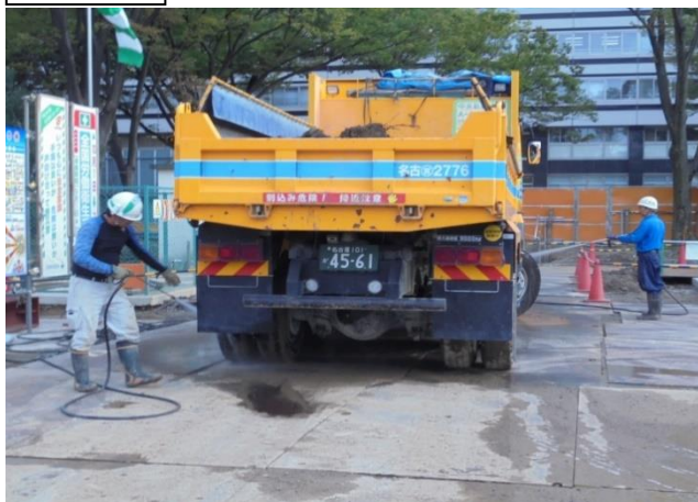
タイヤの洗浄状況
