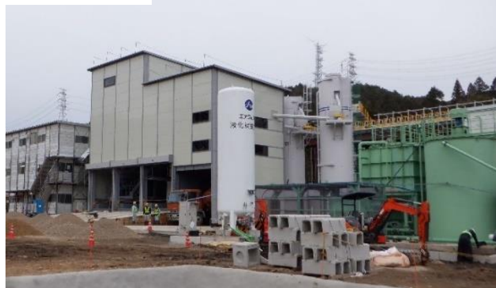
建屋による防音(吹付コンクリートプラント)
