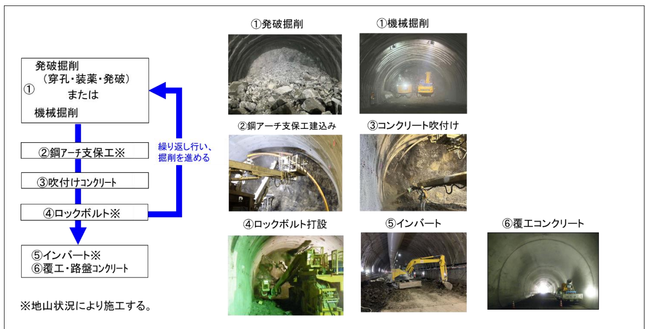
図 2-4-1-15 山岳工法によるトンネルの標準的な施工手順（写真は類似工事の例）
