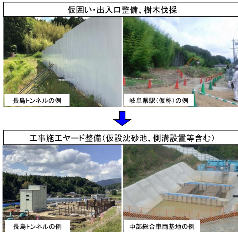
図 2-4-1-3 工事施工ヤード造成の施工手順
