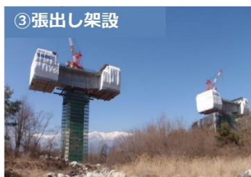
図2-3-2-5 上部工（張出し架設工）の施工手順
