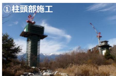
図2-3-2-5 上部工（張出し架設工）の施工手順
