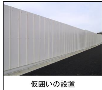
図3-4-1-1 工事施工ヤード等における大気環境に関する計画面の環境保全措置 (写真は類似工事の例)
