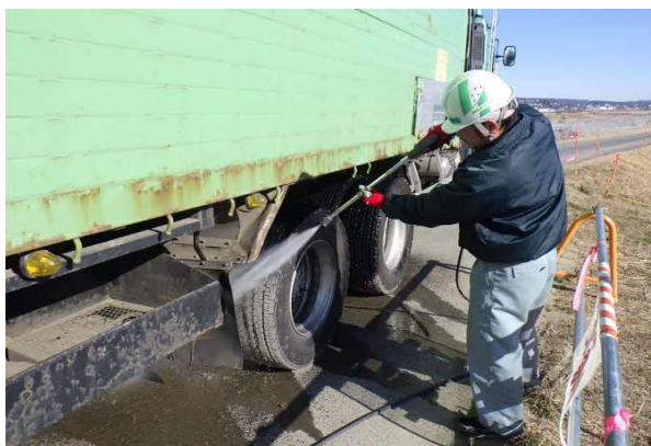
図3-5-1 資材及び機械の運搬に用いる車両の運行による影響を低減させるための環境保全措置 (写真は類似工事の例)
