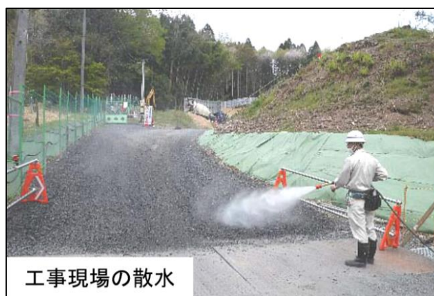
図3-4-1-3 工事施工ヤード等における大気環境に関する工事実施時の環境保全措置 (写真は類似工事の例)
