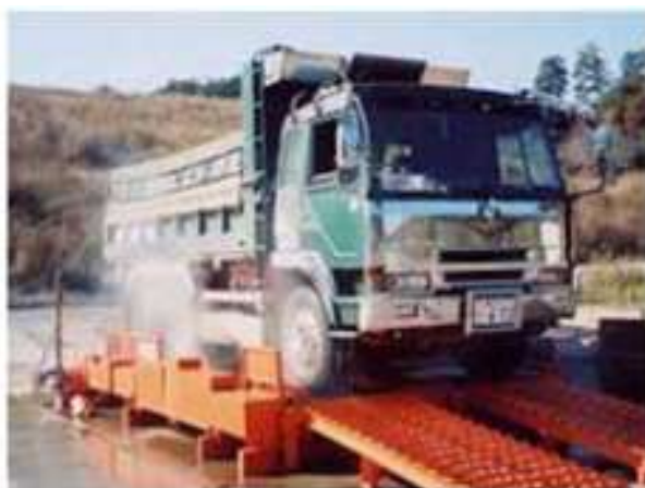
タイヤ洗浄状況
