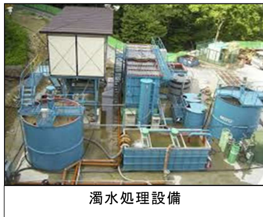
図3-4-2-1 水環境に関する計画面の環境保全措置 (写真は類似工事の例)
