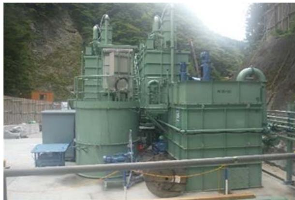
図 3-1-3 濁水処理設備
