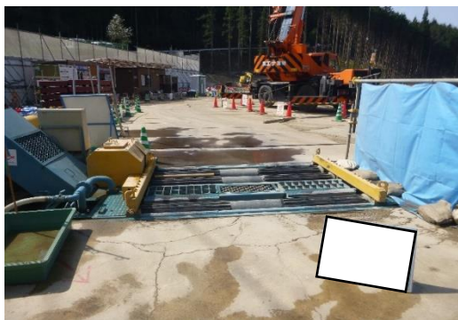
写真4-1-5 外来種の拡大抑制、資材及び機械の 運搬に用いる車両のタイヤの洗浄 (タイヤ洗浄機の設置状況)
