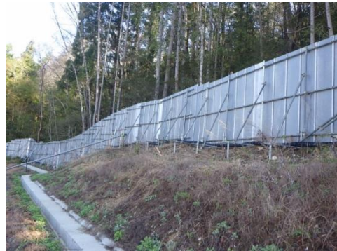
写真4-1-25 仮囲い設置状況
