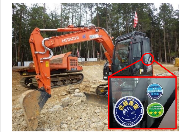
写真4-1-16 排出ガス対策型、低騒音型 建設機械の稼働
