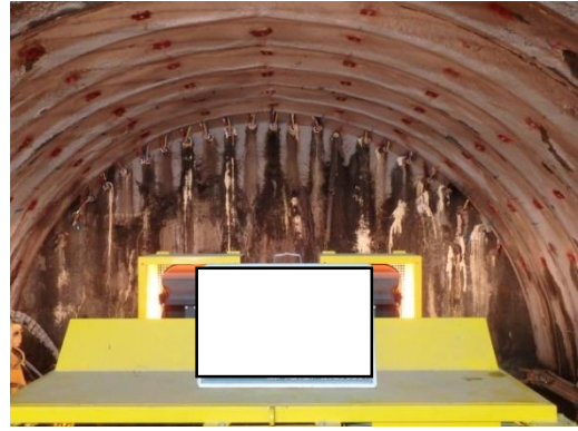
写真4-1-31 適切な構造及び工法の採用 (注入式長尺先受工法 (AGF工法) 施工状況)
