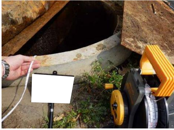
写真4-1-22 地下水等の監視
