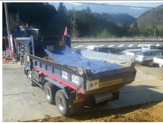
写真4-1-19 荷台への防塵シート敷設状況
