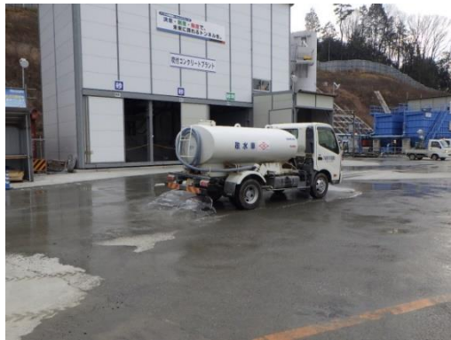
写真4-1-26 散水実施状況
