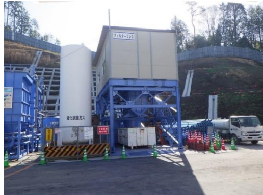
写真4-1-35 建設汚泥の脱水処理
