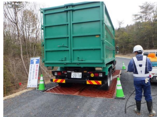
写真4-1-41 タイヤ洗浄状況
