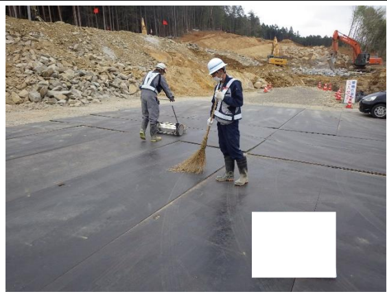
写真4-1-17 工事現場の清掃及び散水状況
