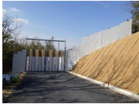
写真4-1-39 仮囲い設置状況
