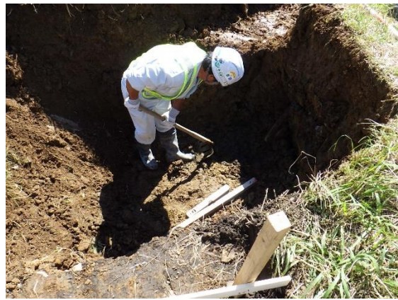
写真4-1-14 工事立会等の実施 (試掘の状況)
