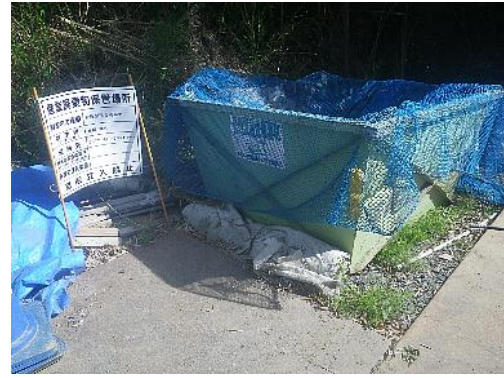
写真4-1-37 副産物の分別・再資源化
