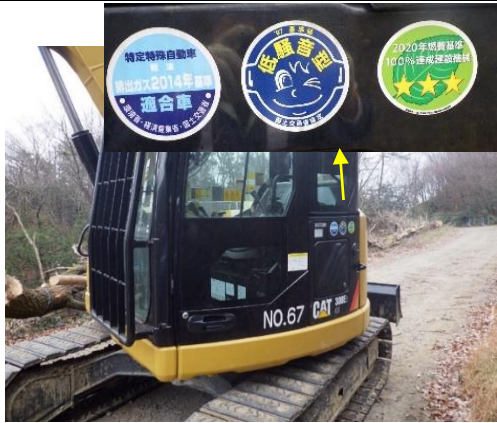
写真4-1-38 排出ガス対策型、低騒音型建設機械の稼働
