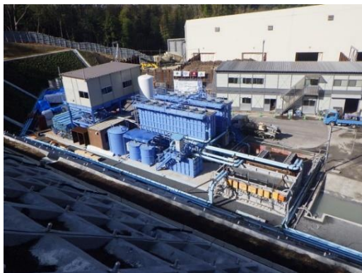
写真4-1-34 工事排水の適切な処理
