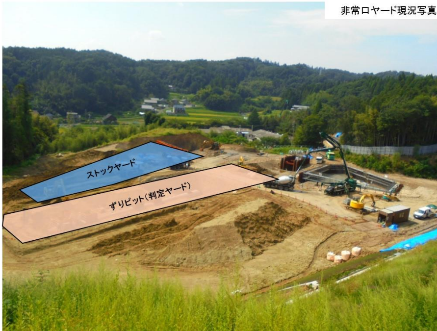
写真1 スtockヤード設置位置
