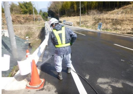
写真4-1-3 工事現場の清掃及び散水
