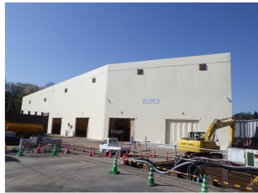
写真4-1-33 仮置き場における発生土の 適切な管理
