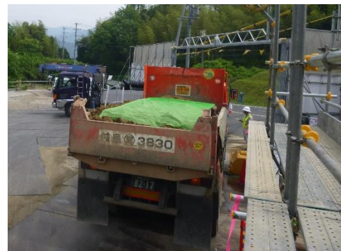
写真4-1-6 荷台への防塵シート敷設状況
