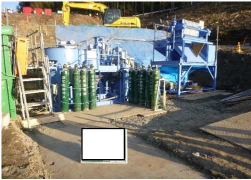
写真4-1-9 工事排水の適切な処理状況
