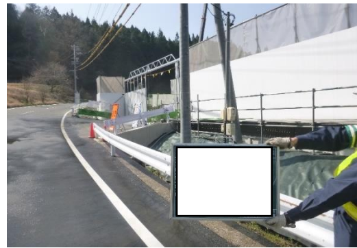
写真4-1-2 仮囲いの設置状況
