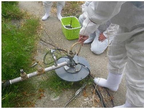
写真4-1-32 地下水等の監視
