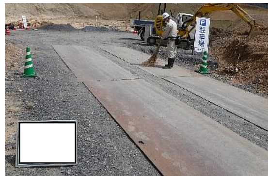
写真4-1-27 車両の出入り口の清掃実施状況
