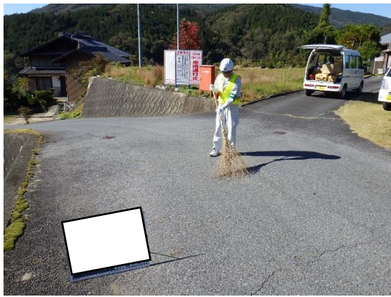
写真4-1-13 車両の出入り口の清掃実施状況
