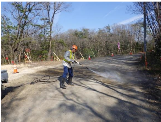
写真4-1-40 散水実施状況
