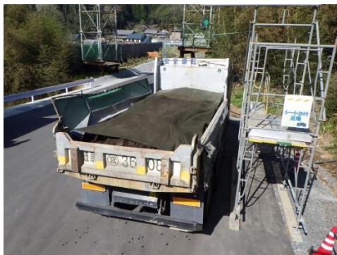
写真4-1-28 荷台への防塵シート敷設状況
