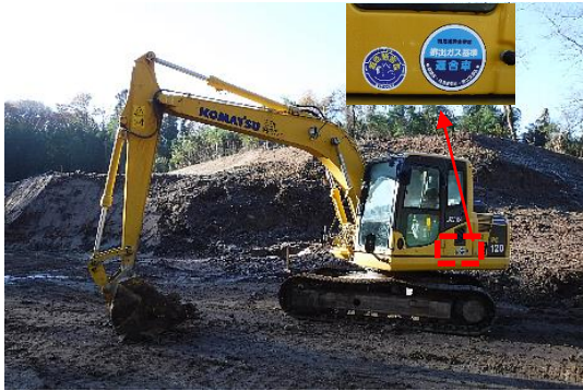
写真4-1-24 排出ガス対策型、低騒音型 建設機械の稼働
