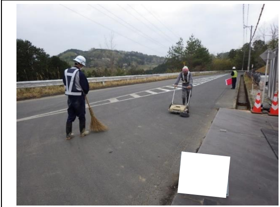
写真4-1-18 車両の出入り口の清掃実施状況
