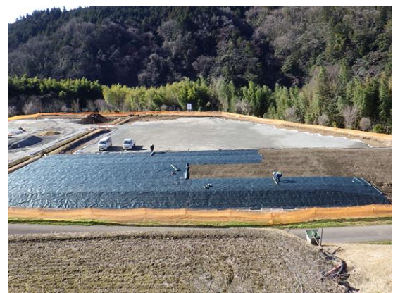
写真4-1-15 重要な種の移植・播種 (耕土仮置き状況)
