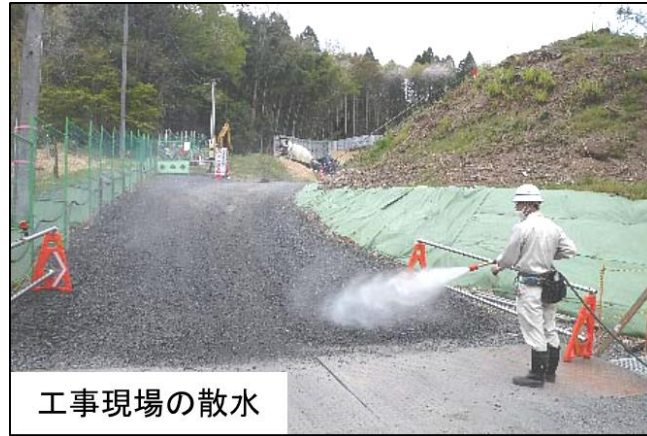
図 3-4-1-2 大気環境に関する工事实施時の環境保全措置 (写真は類似工事の例)
