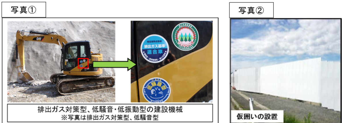
図 3-4-1-1 工事施工ヤード造成等における大気環境に関する計画面の環境保全措置 (写真は類似工事の例)
