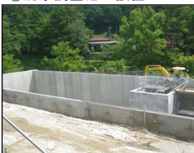
③沈砂調整池の設置
