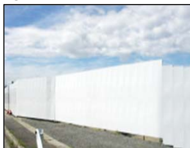
②仮囲い・出入口整備
