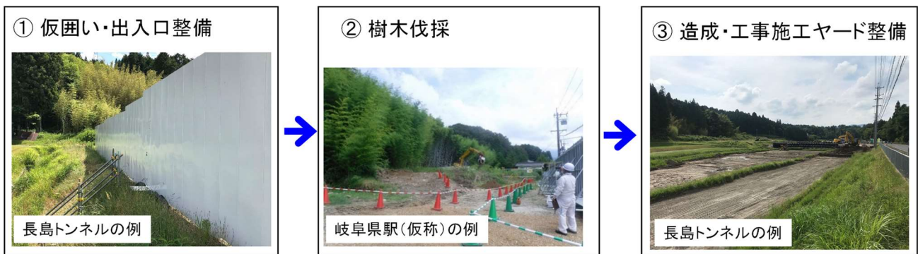
図 2-3-1-1 工事施工ヤード造成の施工手順
