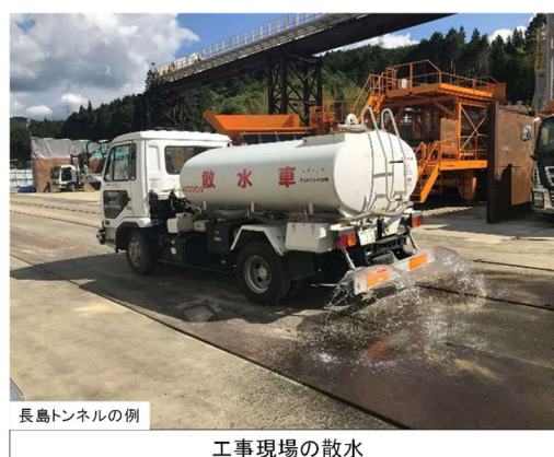
図3-4-1-2 工事施工ヤードにおける大気環境に関する工事实施時の環境保全措置
