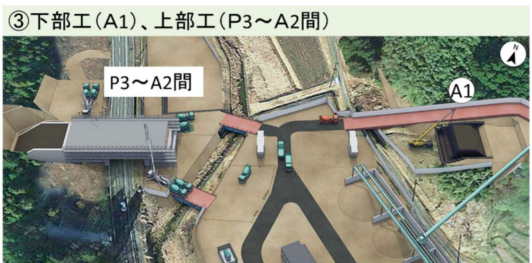
図 2-3-2-1(1) 橋りょう・高架橋工の施工手順
