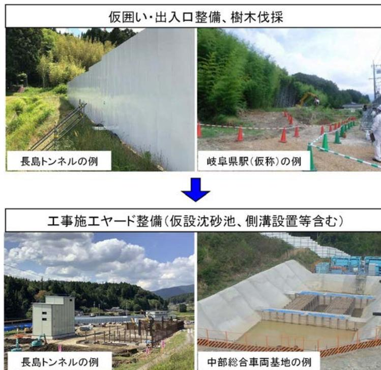
図 2-3-1-1 工事施工ヤード造成の施工手順
