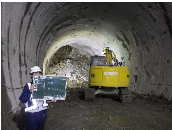
路盤整正状況
