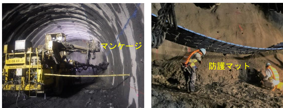
図 6-1 設備的防護対策の例
