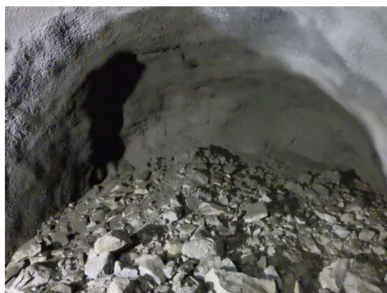
吹付けコンクリート施工完了状況
