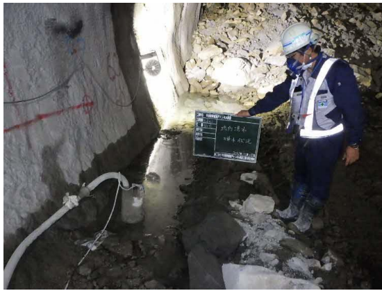
排水処理状況
