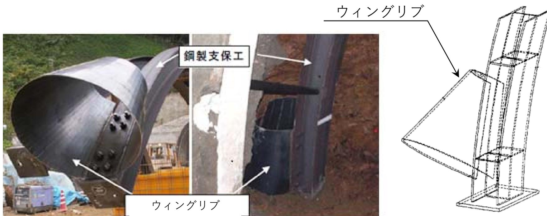
支保脚部の支持面積を増やし、接地圧の低減を図る
