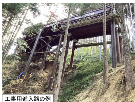
図 2-3-1-4 仮棧橋工の施工手順
