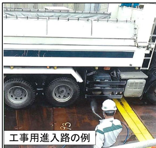
図3-5-1 資材及び機械の運搬に用いる車両の運行による影響を低減させるための環境保全措置
