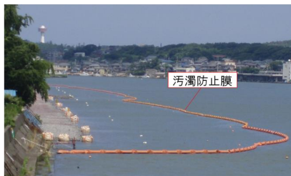
図3-4-2-6 河川内工事における水環境に関する工事实施時の環境保全措置 (写真は類似工事の例)
