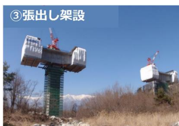
図 2-3-2-6 上部工（張出し架設工）の施工手順
