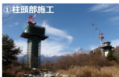
図 2-3-2-6 上部工（張出し架設工）の施工手順
