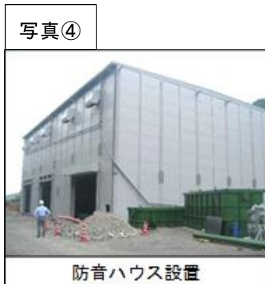
図3-4-1-1 工事施工ヤード等における大気環境に関する計画面の環境保全措置 (写真は類似工事の例)
