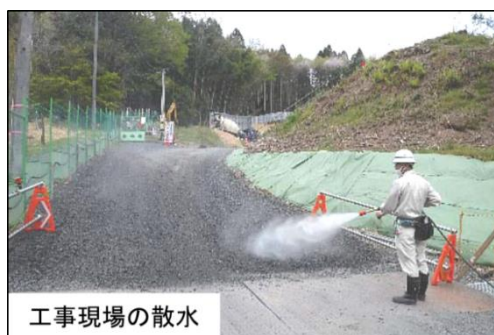
図3-4-1-2 工事施工ヤード等における大気環境に関する工事実施時の環境保全措置
