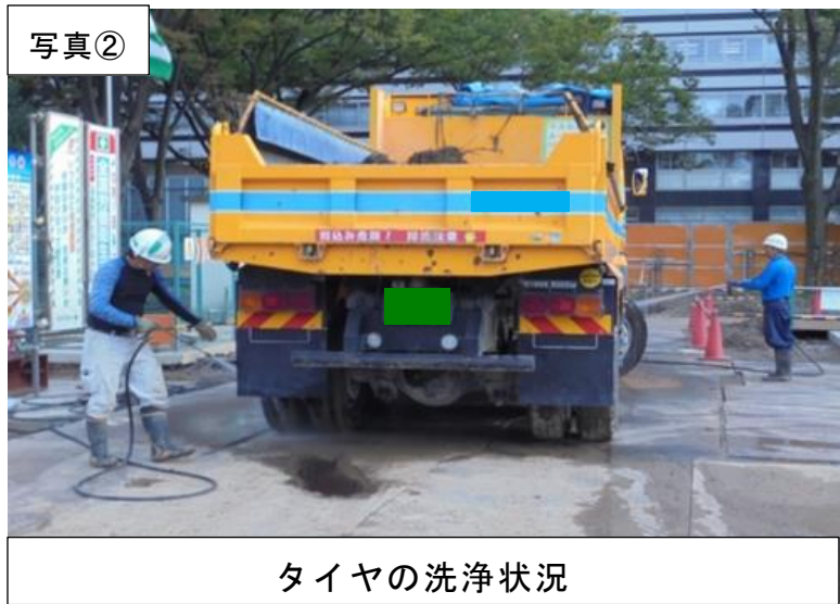
図3-5-1 資材及び機械の運搬に用いる車両の運行による影響を低減させるための環境保全措置 (写真は類似工事の例)
