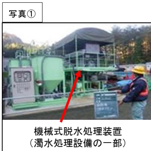
図3-4-5-1 廃棄物等、温室効果ガスに関する計画面の環境保全措置 (写真は類似工事の例)
