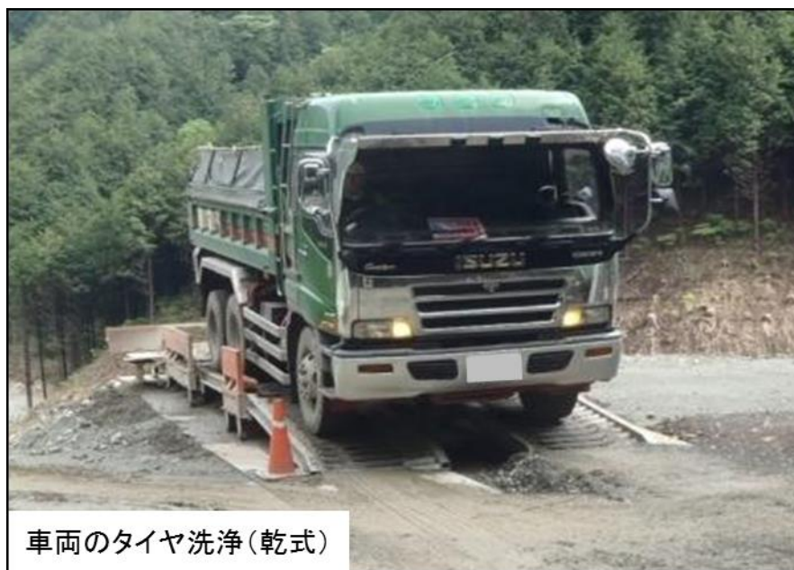
図3-5-1 資材及び機械の運搬に用いる車両の運行による影響を低減させるための環境保全措置
