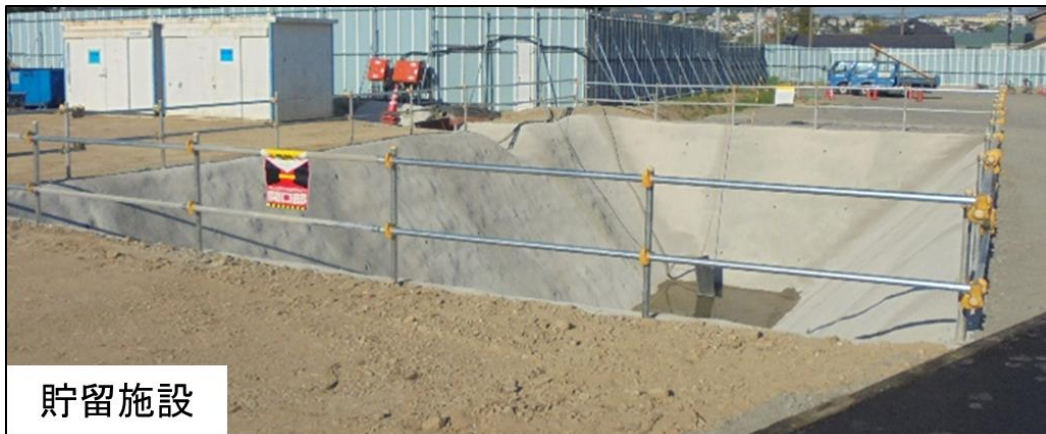
図3-4-2-1 水環境に関する計画面の環境保全措置 (写真は類似工事の例)
