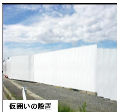
図3-4-1-1 工事施工ヤード等における大気環境に関する計画面の環境保全措置 (写真は類似工事の例)
