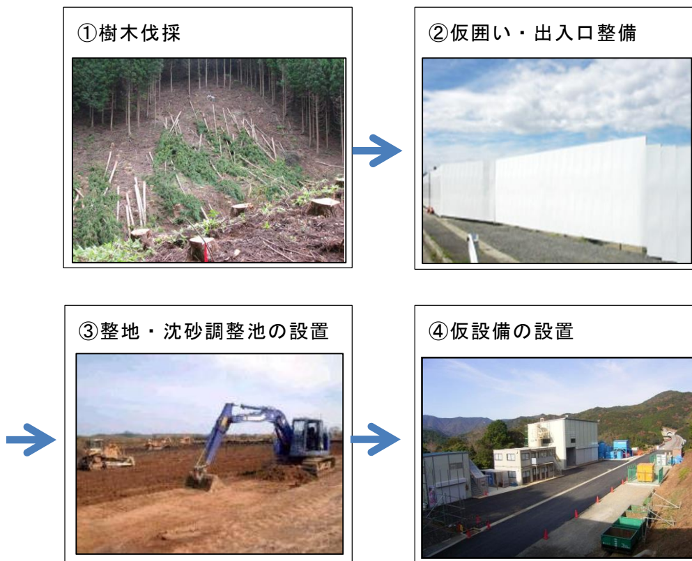
図 2-3-1 工事施工ヤード造成の施工手順（写真は類似工事の例）
