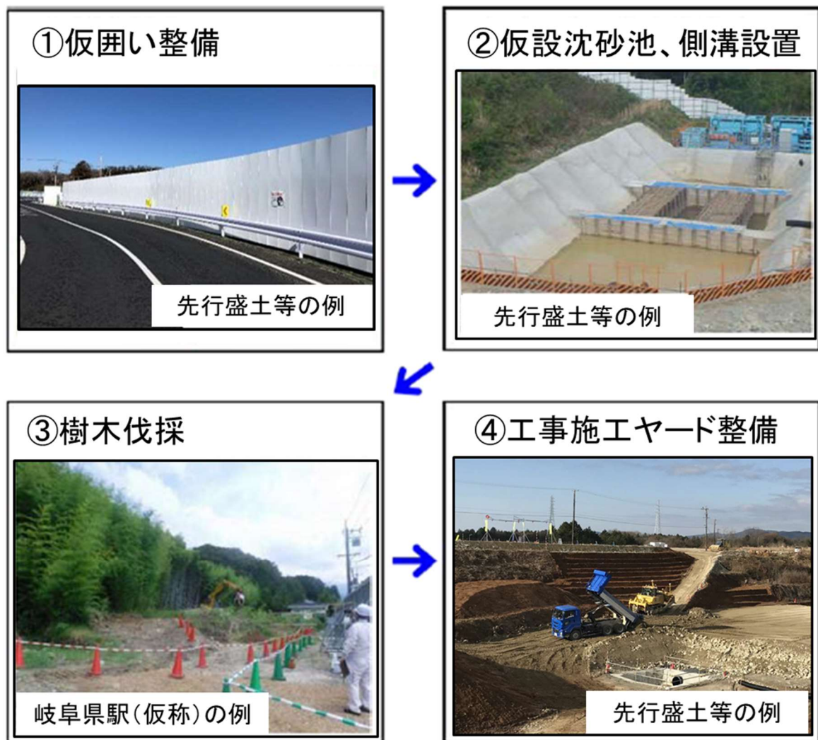
図 2-3-1-1 工事施工ヤード造成の施工手順
