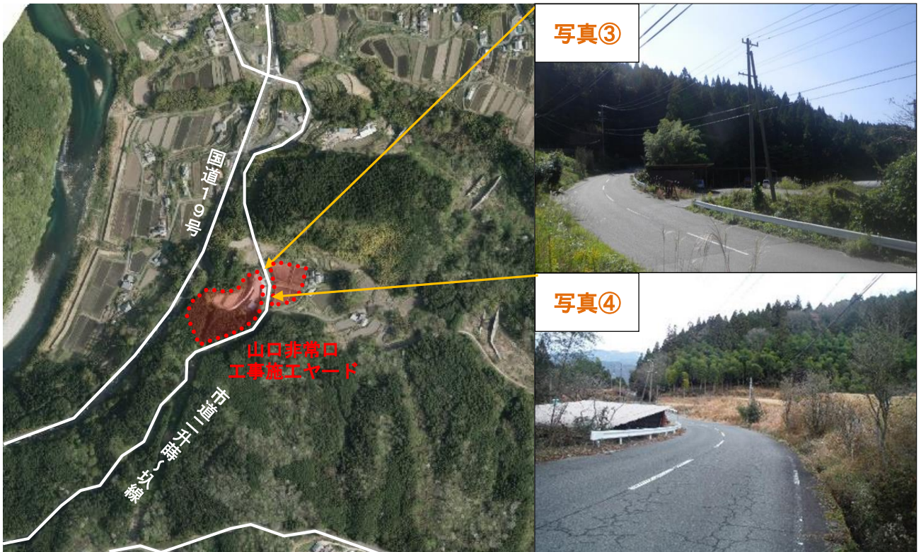
図 2-2-2(2) 山口非常口へ向かう市道二升藜～塚線の現況
