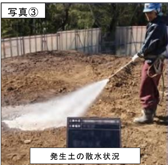
※写真は、山梨リニア実験線工事での例
