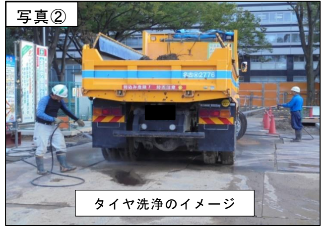
※写真は、他工事での例
