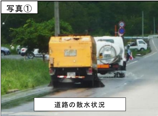
※写真は、山梨リニア実験線工事での例
