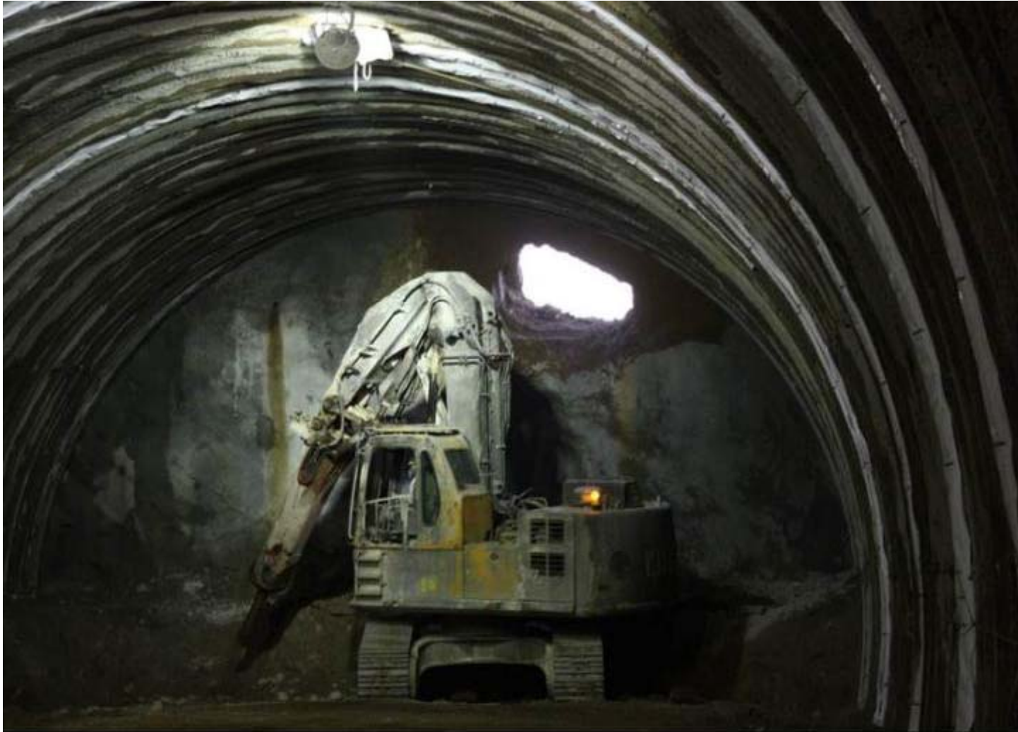
安寺トンネル
