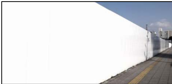
・仮囲い・防音シート等の設置による遮音対策
