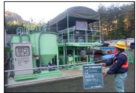
・工事排水の適切な処理 ・工事排水の監視 ・放流時の放流箇所及び水温の調整
