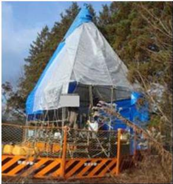
ボーリング調査
