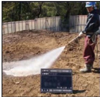
・工事現場の清掃及び散水
