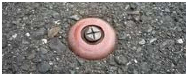
中心杭、横断測量の方向杭、用地幅杭イメージ
