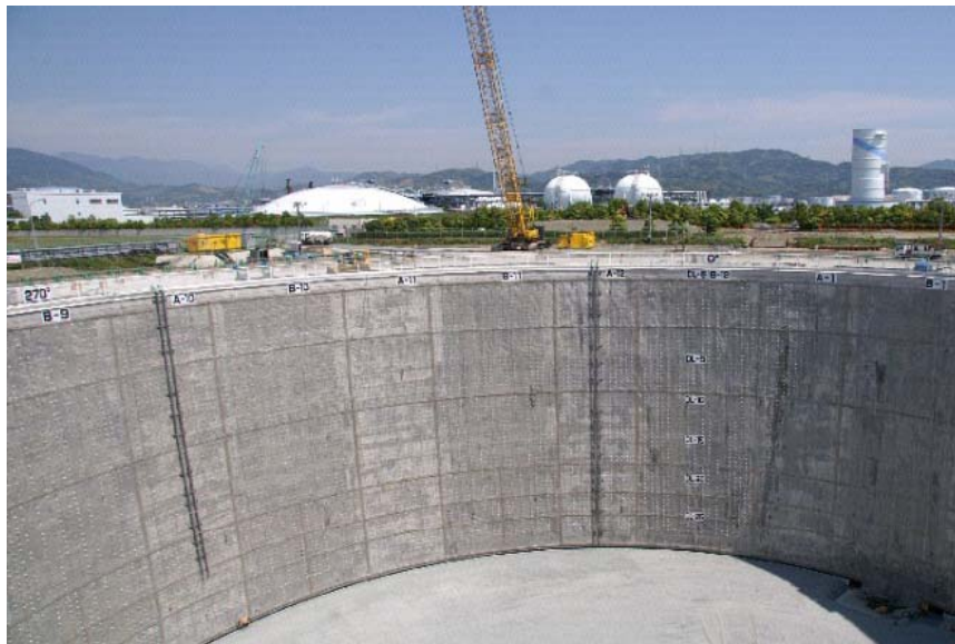
「地中連続壁協会HP」より
