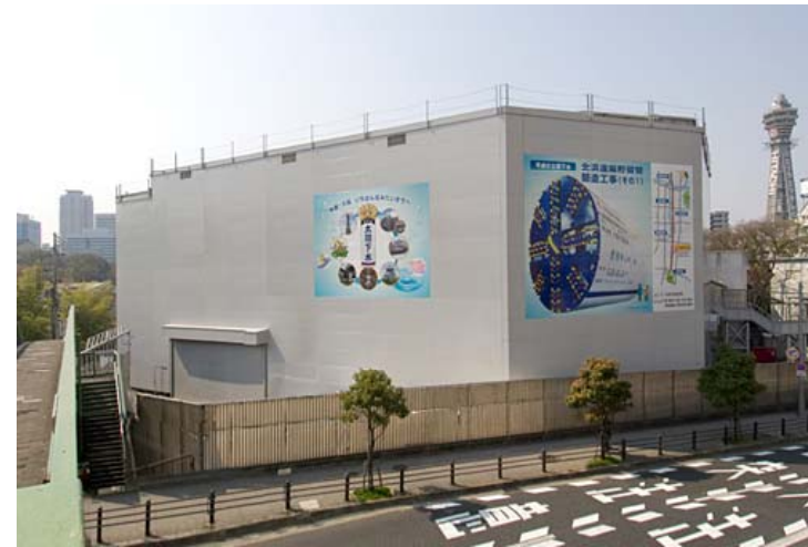
仮設防音設備イメージ
