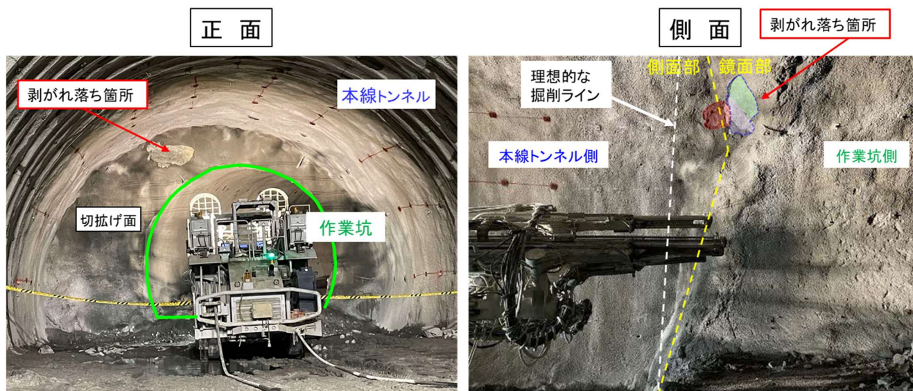
図4-5 剥がれ落ちた箇所の鏡面
