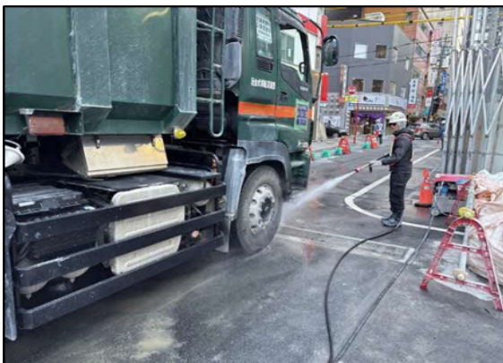
写真 4-1-5-9 資材及び機械の運搬に用いる車両の出入口、周辺道路の清掃及び散水、タイヤの洗浄
