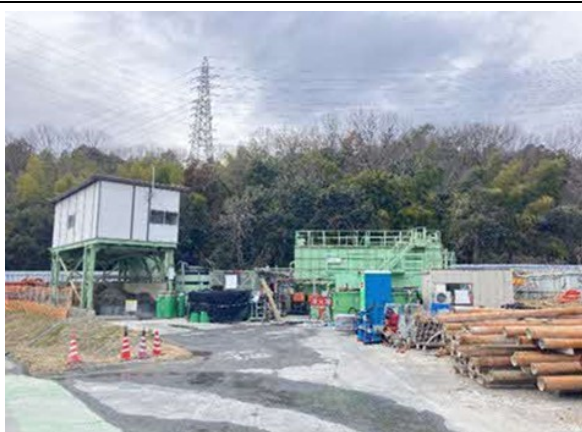
写真 4-1-1-7 工事排水の適切な処理
