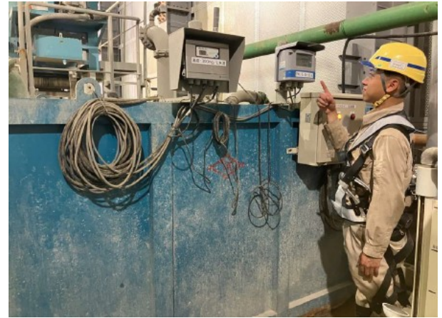
写真 4-1-3-8 工事排水の監視
