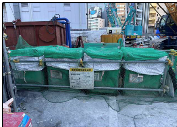
写真 4-1-5-15 副産物の分別、再資源化
