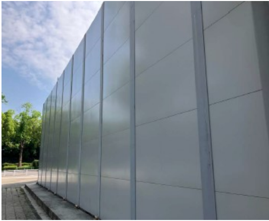
写真 4-1-3-1 仮囲い・防音シート等の設置 (仮囲いの設置)
