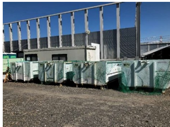
写真 4-1-2-14 副産物の分別、再資源化
