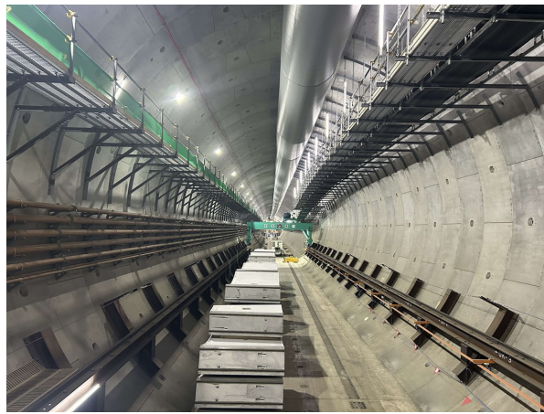
写真 4-1-3-9 適切な構造及び工法の採用 (密閉性の高いシールド工法の採用)
