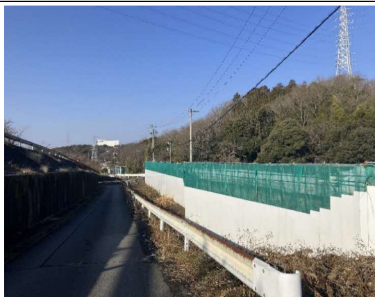
写真 4-1-1-1 仮囲い等の設置
