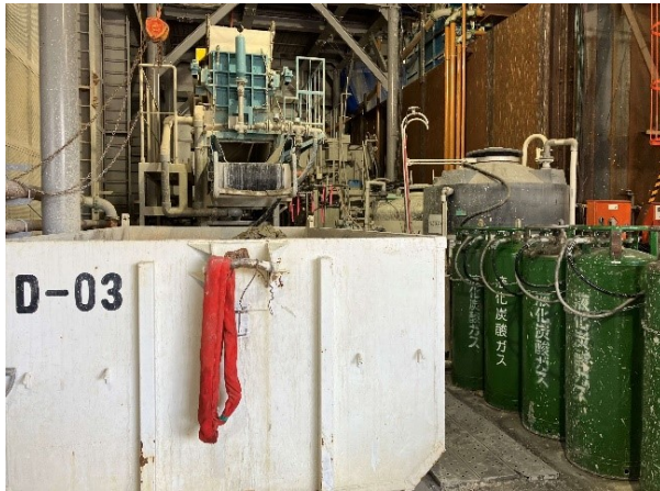
写真 4-1-3-7 工事排水の適切な処理
