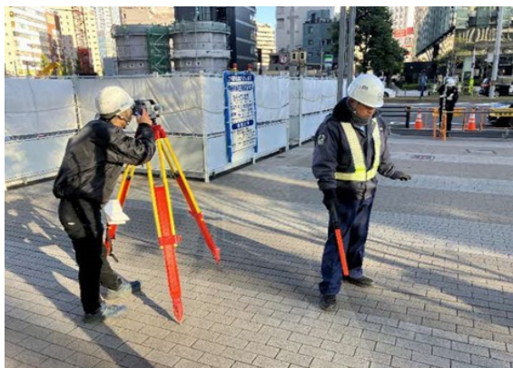
写真 4-1-5-13 山留め材及び周辺地盤の 計測管理
