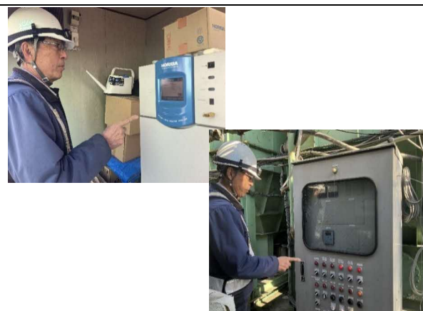
写真 4-1-1-8 工事排水の監視
