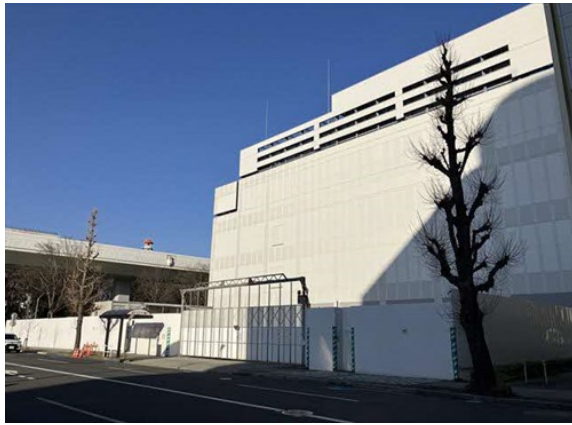
写真 4-1-4-1 仮囲い等の設置
