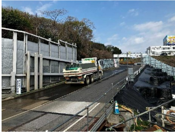
写真 4-1-2-7 資材及び機械の運搬に用いる 車両の出入口、周辺道路の清掃 及び散水、タイヤの洗浄
