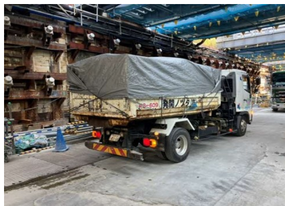
写真 4-1-5-8 荷台への防じんシート敷設及び散水
