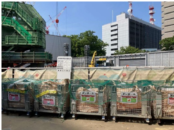
写真 4-1-3-11 副産物の分別、再資源化
