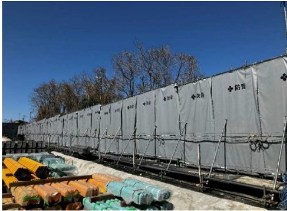
写真 4-1-2-1 仮囲い・防音シート等の設置
