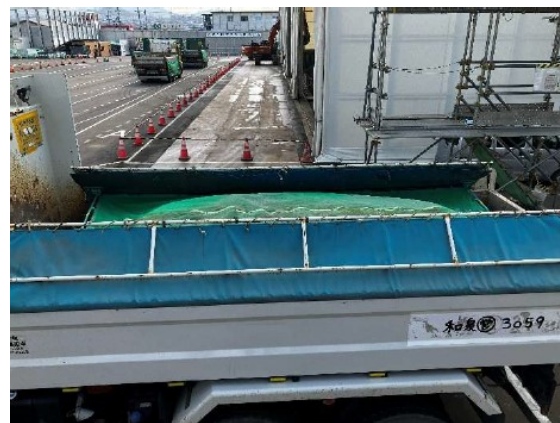
写真 4-1-2-6 荷台への防じんシート敷設及び 散水
