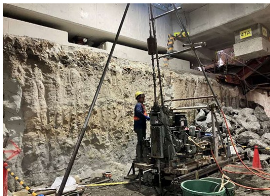
写真 4-1-5-14 発生土に含まれる重金属等の 定期的な調査
