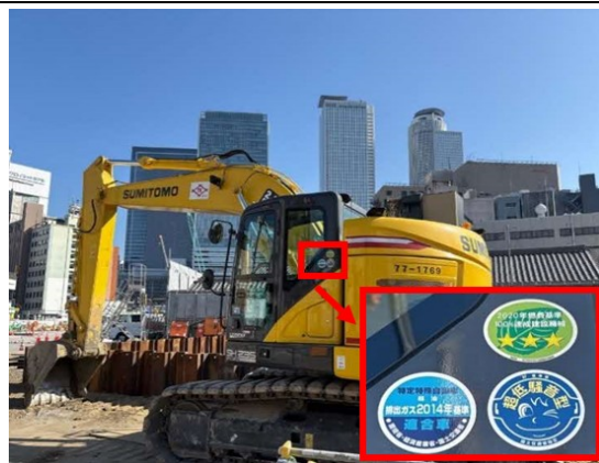
写真 4-1-5-4 低騒音型建設機械の採用
