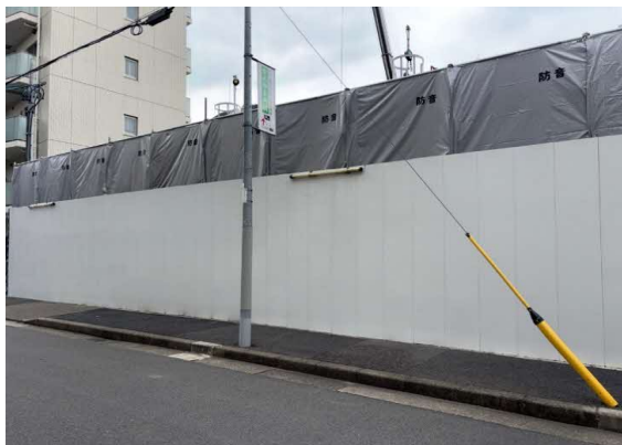
写真 4-1-5-1 仮囲い・防音シートの設置
