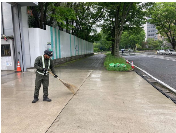
写真 4-1-3-5 工事現場の清掃及び散水 資材及び機械の運搬に用い車両の 出入口、周辺道路の清掃及び散水、 タイヤの洗浄
