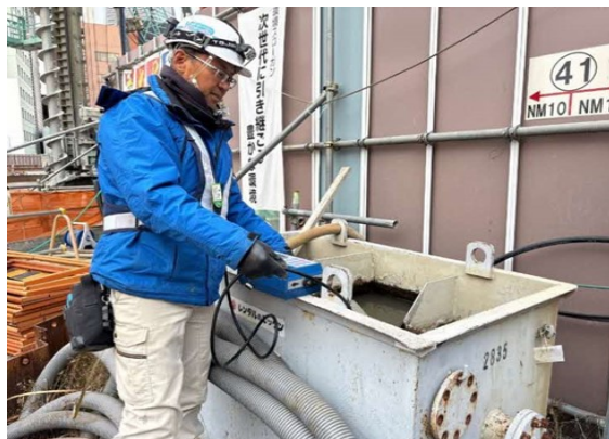
写真 4-1-5-10 工事排水の適切な処理 工事排水の監視
