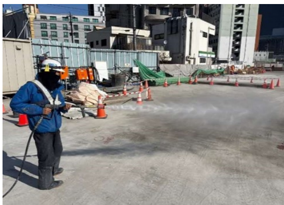
写真 4-1-5-7 工事現場の清掃及び散水
