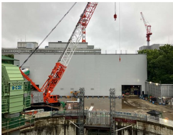
写真 4-1-3-13 仮囲い・防音シート等の設置 仮置場における発生土の適切な 管理（防音ハウスの設置）
