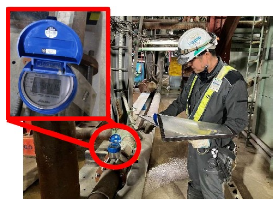
写真 4-1-2-10 工事排水の監視
