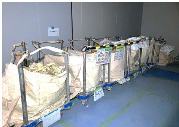
写真 4-1-4-5 副産物の分別、再資源化
