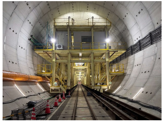
写真 4-1-2-8 適切な構造及び工法の採用 (密閉性の高いシールド工法の採用)
