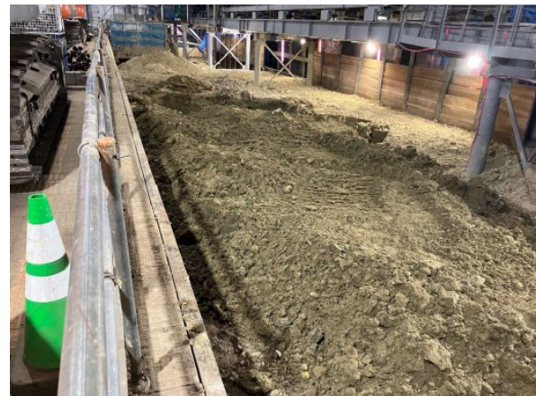
写真 4-1-3-12 仮置場における発生土の適切な 管理（土砂ピットの設置）
