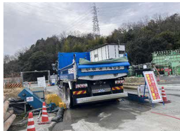
写真 4-1-1-6 資材及び機械の運搬に用いる車両の出入口、周辺道路の清掃及び散水、タイヤの洗浄 荷台への防塵シート敷設及び散水 外来種の拡大抑制
