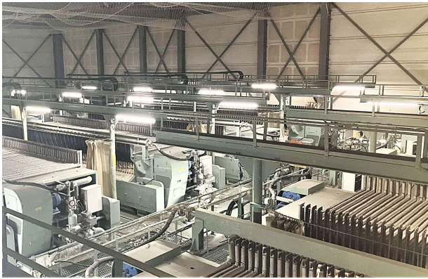
写真 4-1-2-13 建設汚泥の脱水処理 仮囲い・防音シート等の設置 (防音ハウスの設置)
