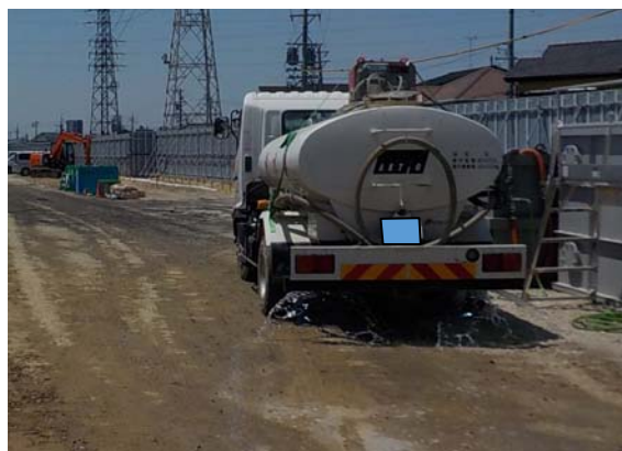
写真4-1-3-4 工事現場の清掃、散水
