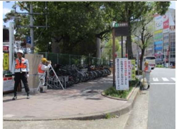
写真4-1-6-10 山留め材及び周辺地盤の計測管理
