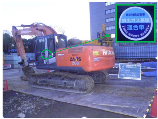
写真4-1-4-2 排出ガス対策型建設機械の採用
