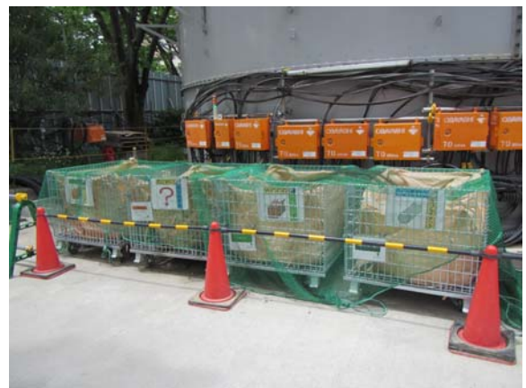
写真4-1-4-12 副産物の分別、再資源化
