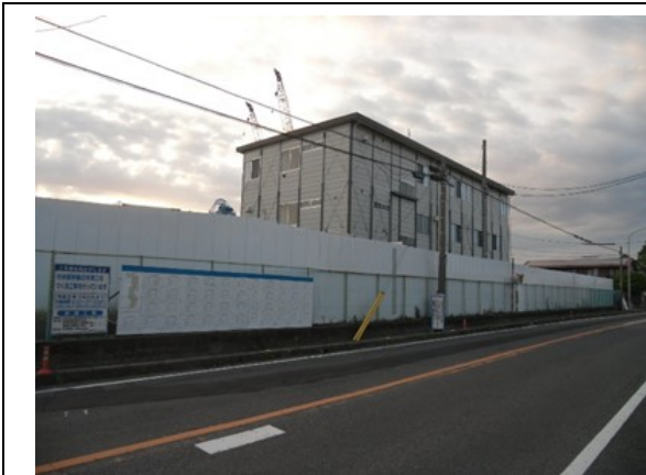
写真4-1-2-1 仮囲い等の設置
