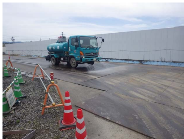
写真4-1-2-4 工事現場の清掃、散水
