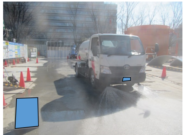
写真4-1-4-6 工事現場の清掃、散水
