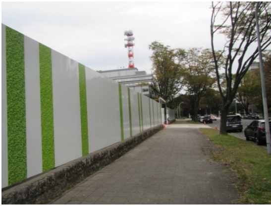
写真4-1-4-1 仮囲い等の設置
