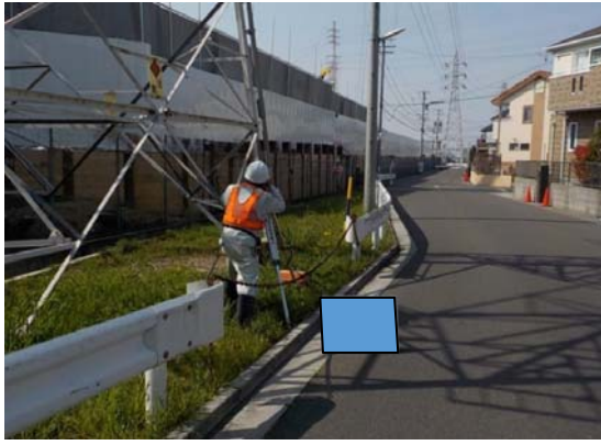
写真4-1-3-7 周辺地盤の計測管理
