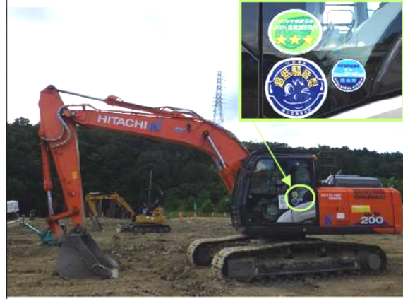
写真4-1-1-2 排出ガス対策型、低騒音型建設機械の採用
