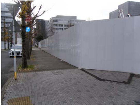
写真4-1-5-1 仮囲い等の設置
