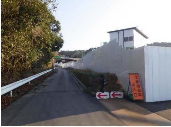
写真4-1-1-1 仮囲い等の設置
