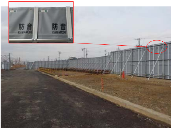
写真4-1-3-1 仮囲い・防音シート等の設置
