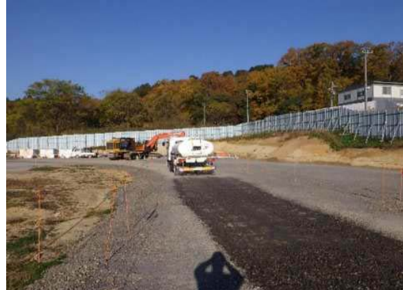
写真4-1-1-4 工事現場の清掃及び散水
