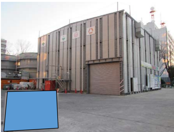
写真4-1-4-5 防音ハウスの設置
