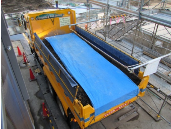
写真4-1-4-7 荷台への防じんシート敷設及び散水
