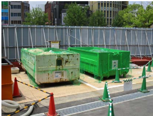
写真4-1-6-11 副産物の分別、再資源化
