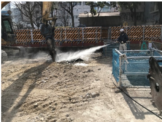
写真 4-1-5-5 工事現場の清掃及び散水
