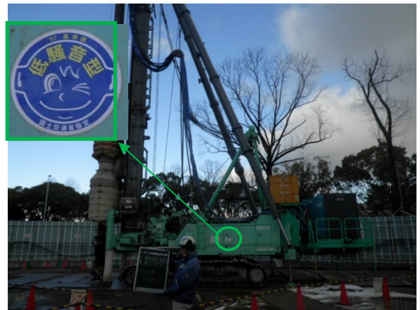
写真4-1-4-4 低騒音型建設機械の採用
