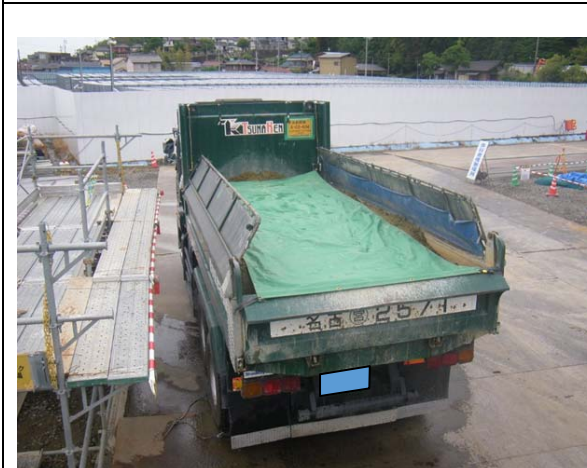
写真4-1-2-5 荷台への防じんシート敷設及び散水
