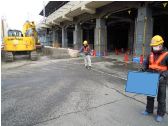
写真 4-1-6-5 工事現場の清掃、散水
