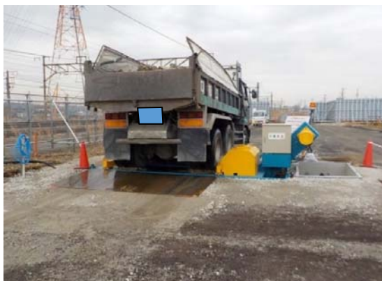
写真4-1-3-5 資材及び機械の運搬に用いる車両 の出入口の清掃及び散水、タイヤの 洗浄
