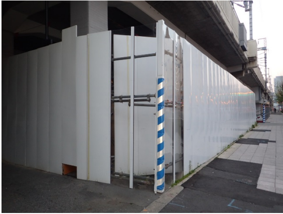
写真4-1-6-1 仮囲い等の設置
