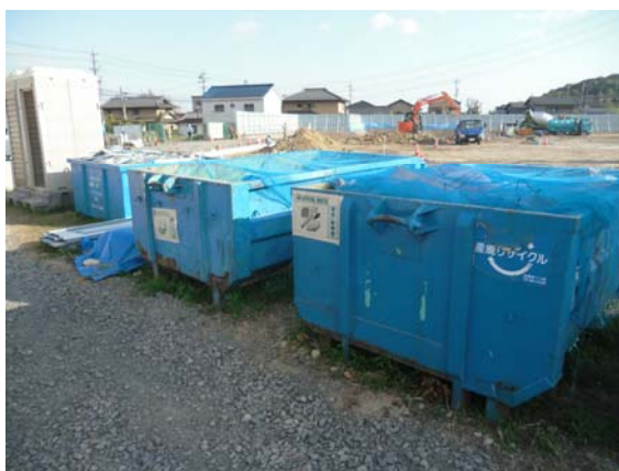
写真4-1-2-11 副産物の分別、再資源化
