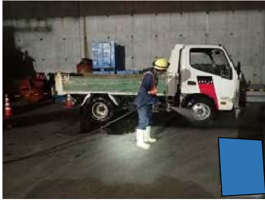
写真4-1-6-7 資材及び機械の運搬に用いる車両の出入口、周辺道路の清掃及び散水、タイヤの洗浄
