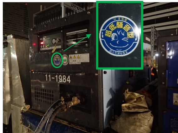
写真4-1-6-4 低騒音型建設機械の採用
