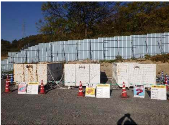
写真4-1-1-9 副産物の分別、再資源化
