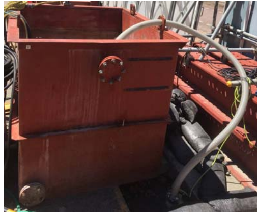
写真4-1-6-8 工事排水の適切な処理
