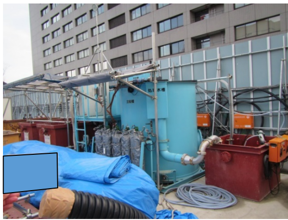
写真4-1-4-9 工事排水の適切な処理
