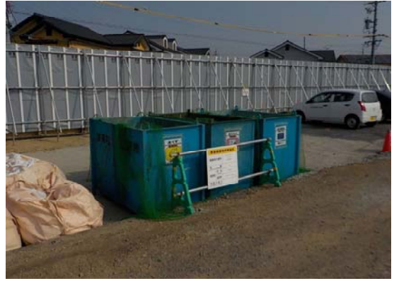
写真4-1-3-8 副産物の分別、再資源化
