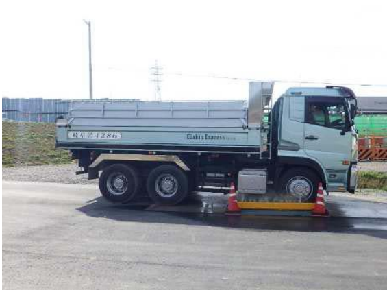
写真4-1-1-5 資材及び機械の運搬に用いる車両の出入り口や周辺道路の清掃及び散水、タイヤの洗浄
