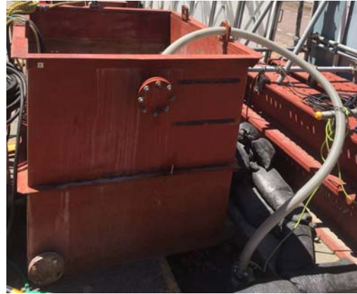
写真3-1-3-8 工事排水の適切な処理
