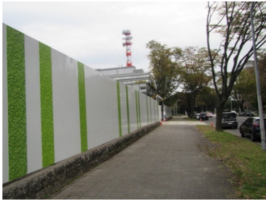
写真3-1-2-1 仮囲い等の設置
