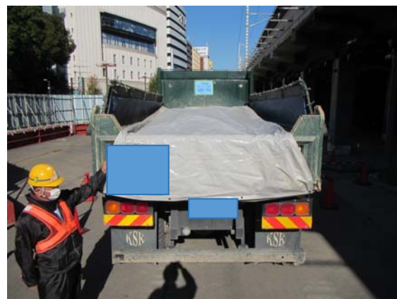
写真3-1-3-6 荷台への防じんシート敷設及び散水
