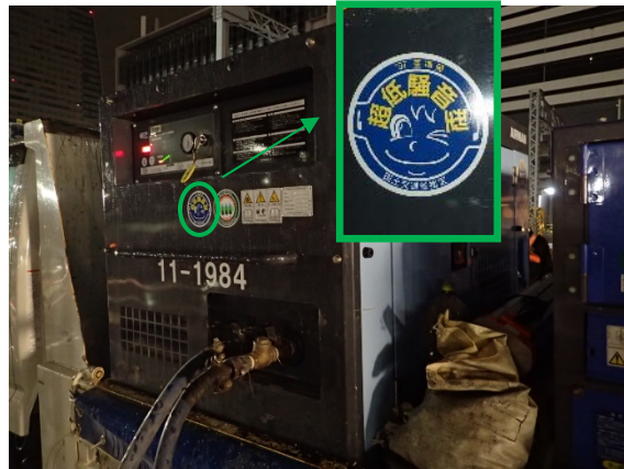
写真3-1-3-4 低騒音型建設機械の採用
