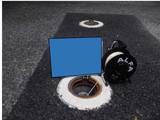
写真3-1-3-9 地下水の継続的な監視
