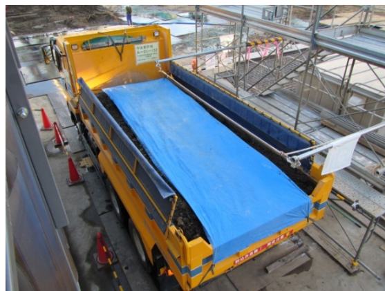
写真3-1-2-6 荷台への防じんシート敷設及び散水
