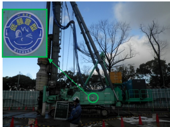
写真3-1-2-4 低騒音型建設機械の採用
