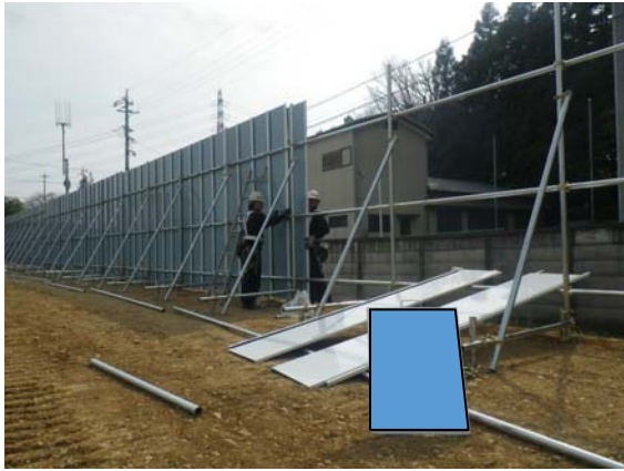
写真3-1-1-1 仮囲い等の設置
