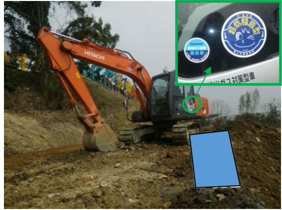
写真3-1-1-2 排出ガス対策型建設機械の採用 低騒音型建設機械の採用
