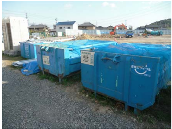
写真3-1-1-8 副産物の分別、再資源化
