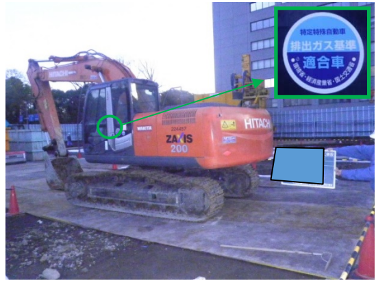
写真3-1-2-2 排出ガス対策型建設機械の採用
