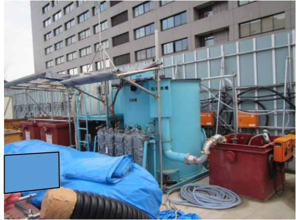
写真3-1-2-8 工事排水の適切な処理
