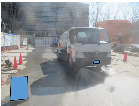
写真3-1-2-5 工事現場の清掃、散水
