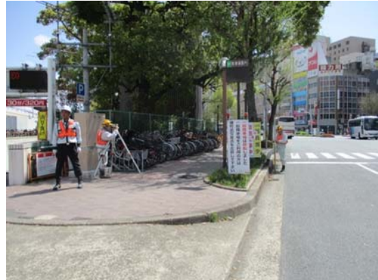
写真3-1-3-10 山留め材及び周辺地盤の計測管理
