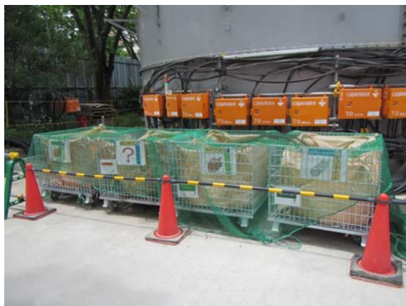
写真3-1-2-11 副産物の分別、再資源化
