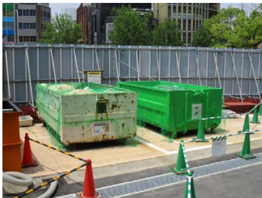
写真3-1-3-11 副産物の分別、再資源化
