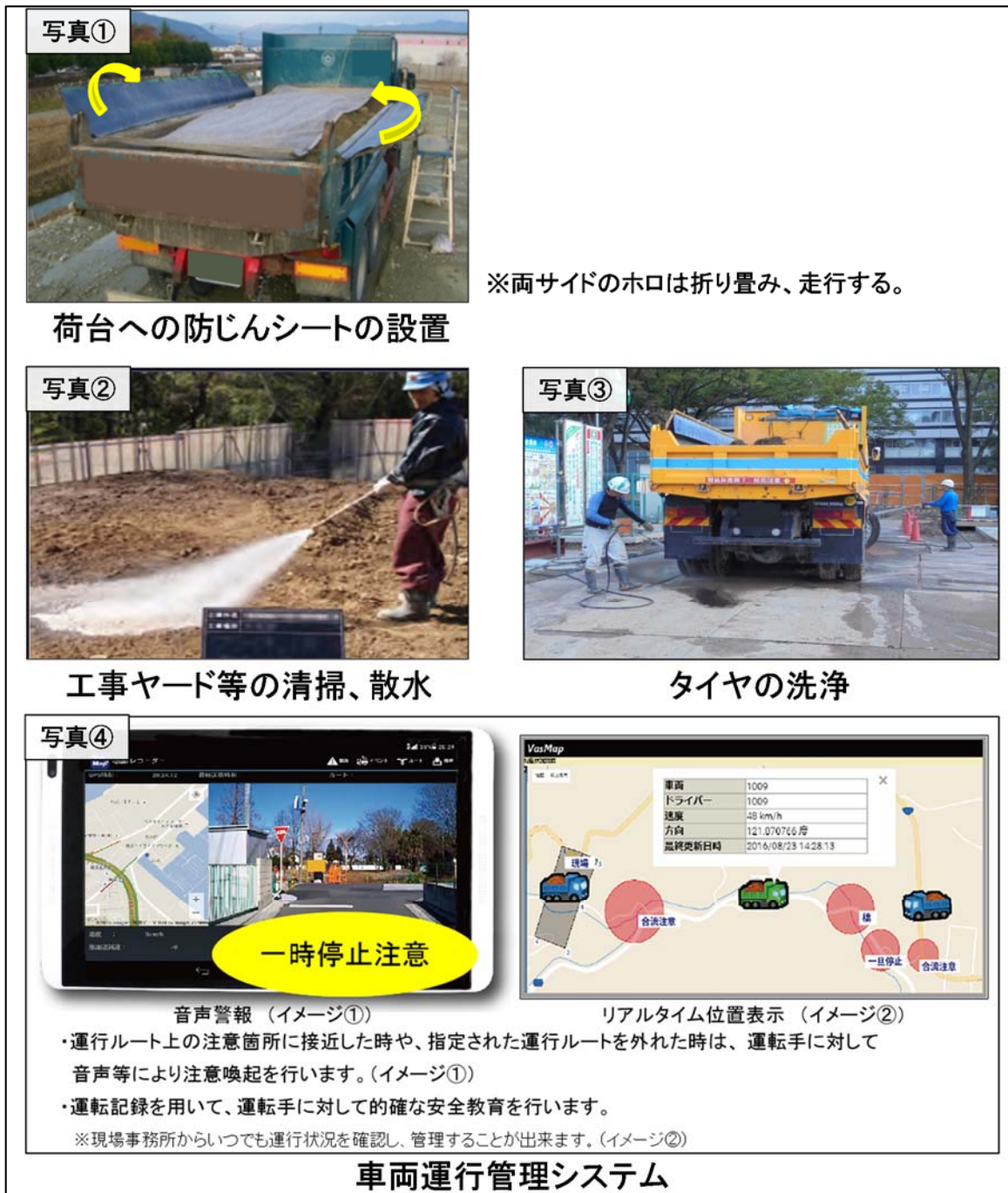
図 3-4 資材及び機械の運搬に用いる車両の運行による影響を低減するための環境保全措置
