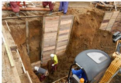
図 2-4(2) 仮土留杭工の施工位置及び手順（写真は類似工事の例）
