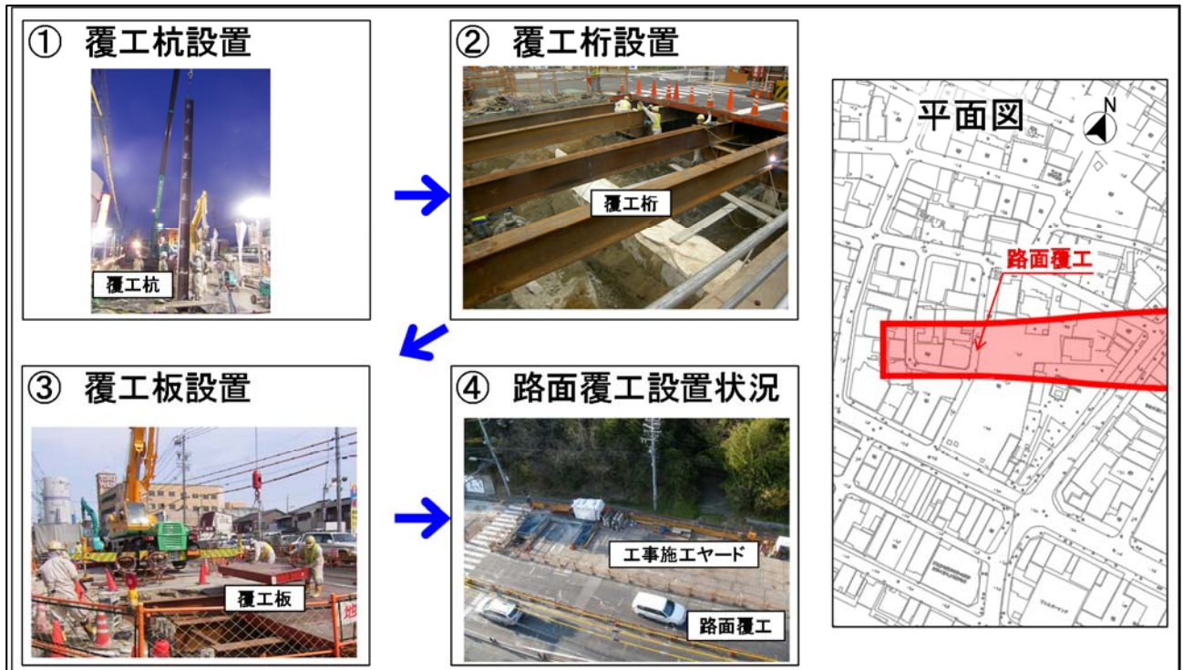
図 2-7(4) 路面覆工（西工区）の施工位置及び手順
