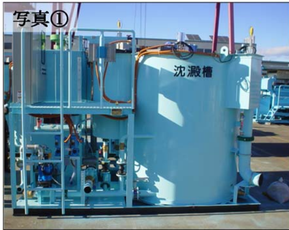
濁水処理設備 (工事施工ヤード内に設置)
