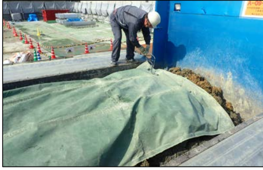
荷台への防じんシートの設置(写真①)
