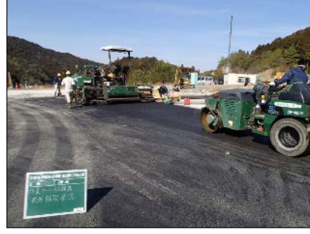
工事施工ヤードの舗装(写真②)
