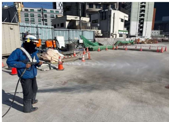
写真 7-1-3-7 工事現場の清掃及び散水
