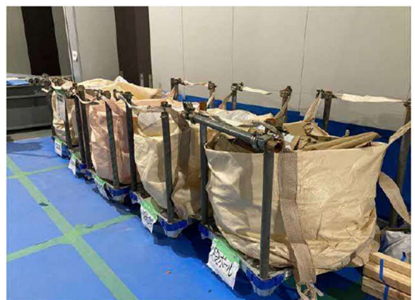
写真 7-1-2-6 副産物の分別、再資源化
