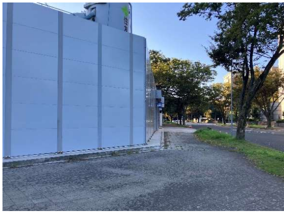
写真7-1-1-1 仮囲い・防音シート等の設置
