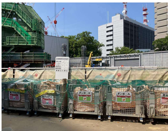
写真 7-1-1-13 副産物の分別、再資源化
