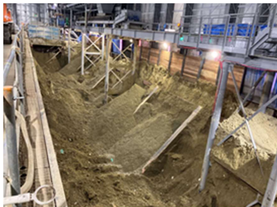
写真 7-1-1-14 仮置場における発生土の適切な管理
