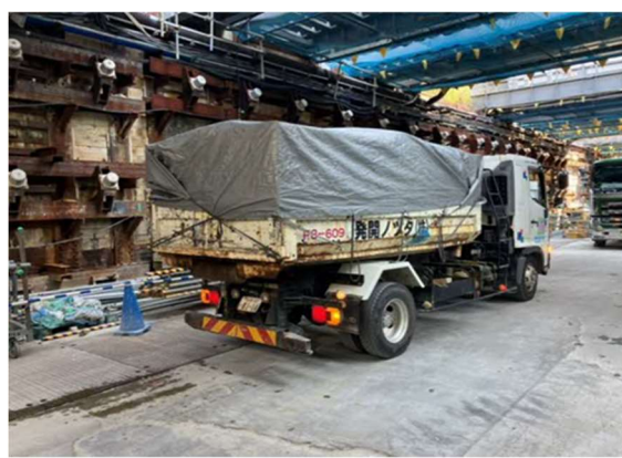
写真 7-1-3-8 荷台への 防じんシート敷設及び散水
