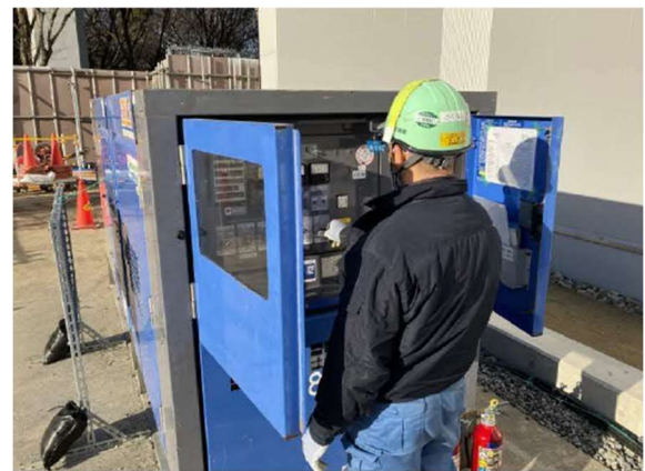
写真 7-1-2-4 建設機械の点検 及び整備による性能維持
