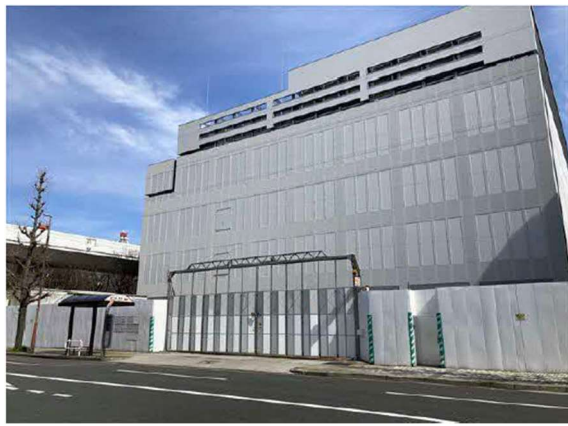
写真 7-1-2-1 仮囲い等の設置状況
