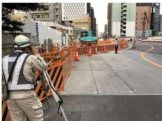
写真 7-1-3-15 山留め材及び周辺地盤の計測管 理
