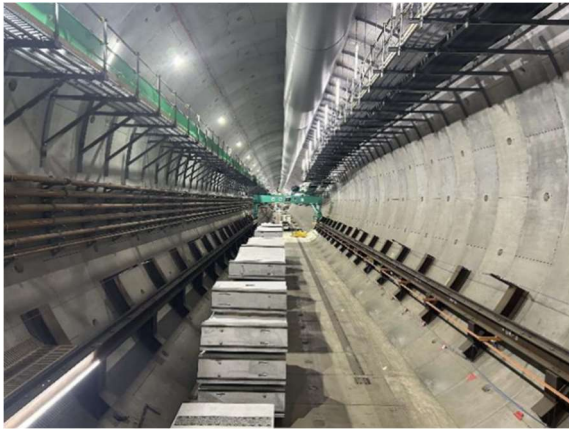
写真 3-2-3-1 (1) 第一中京圏トンネル（名城工区）
