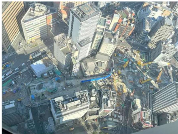
写真 3-2-3-1 (3) 名古屋駅（東工区）
