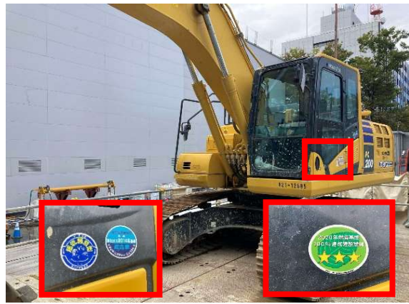
写真7-1-1-2 排出ガス対策型建設機械の採用 低騒音型建設機械の採用
