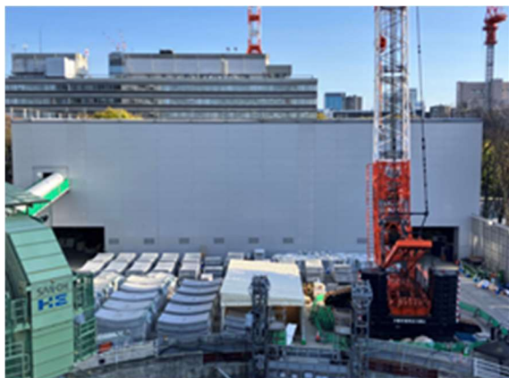
写真 7-1-1-15 仮囲い・防音シート等の設置 仮置場における発生土の適切な管理
