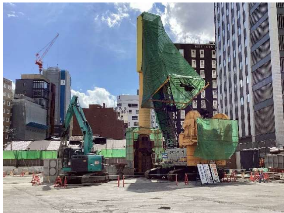
写真 3-2-3-1 (4) 名古屋駅（東工区）
