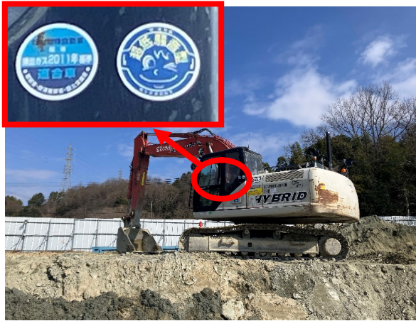
写真 6-1-1 低騒音型建設機械の採用
