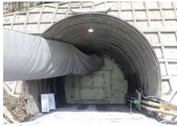
写真 6-1-2 トンネル坑口への防音扉の設置
