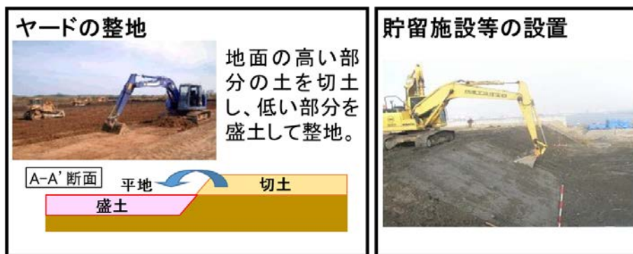
図 2-4 工事施工ヤード等造成 (写真は類似工事の例)
