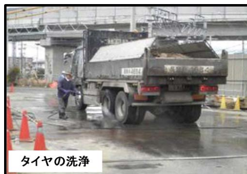
図 3-9 資材及び機械の運搬による影響を低減させるための環境保全措置（写真は類似工事の例）
