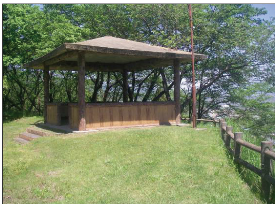
現地の状況（休憩所）
