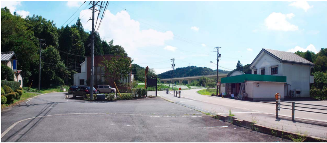
図 13-1-2-15 久々利高架橋
