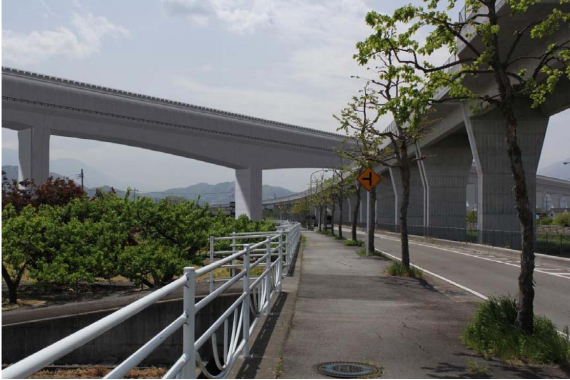
圖 13-1-2-10 中部橫斷自動車道架道橋
