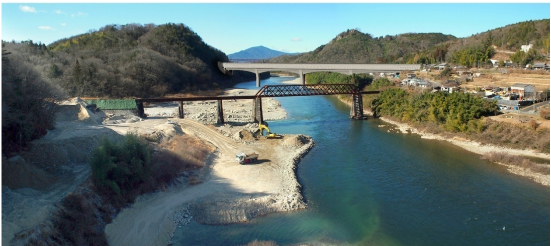
图 13-1-2-14 第 2 木曾川橋梁
