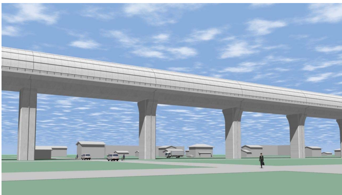
図 13-1-2-1 桁式高架橋
