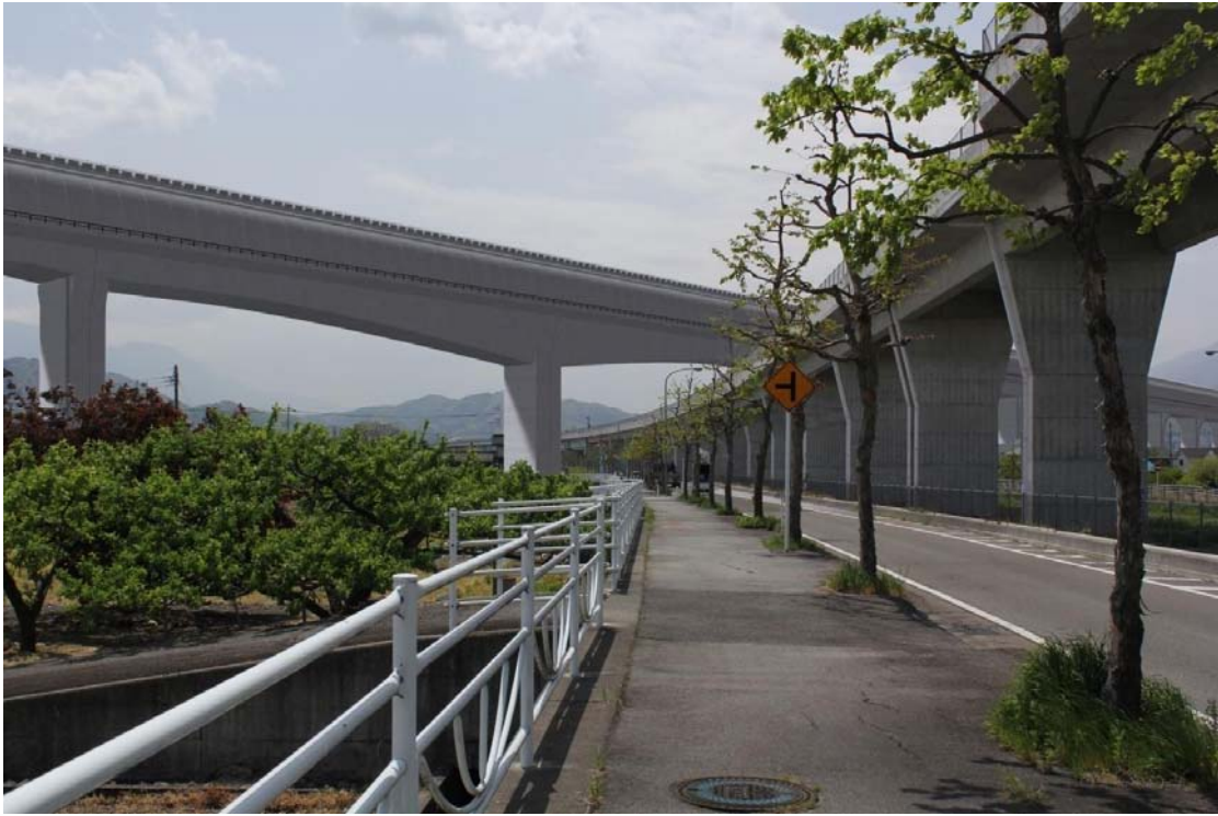
图 13-1-2-10 中部横断道架道橋
