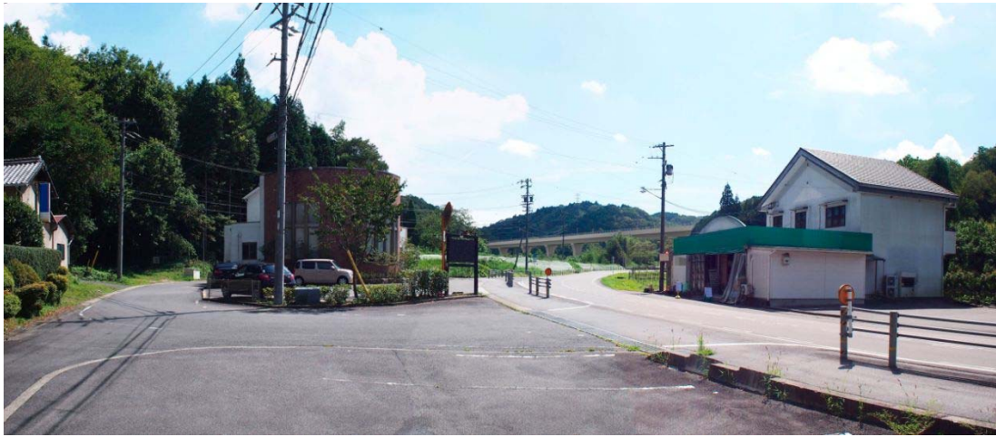
図 13-1-2-15 久々利高架橋
