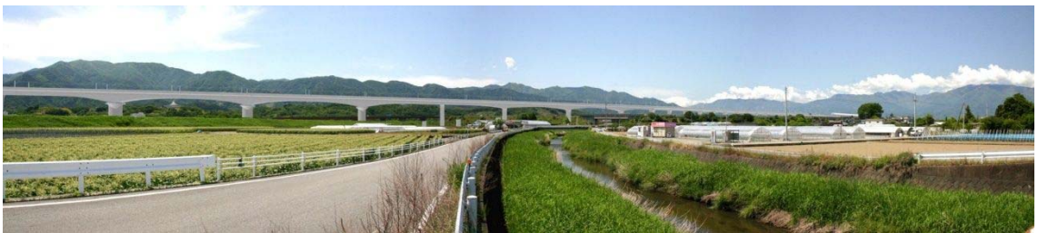
图 13-1-2-7 笛吹川・濁川橋梁及び第2中央自動車道架道橋
