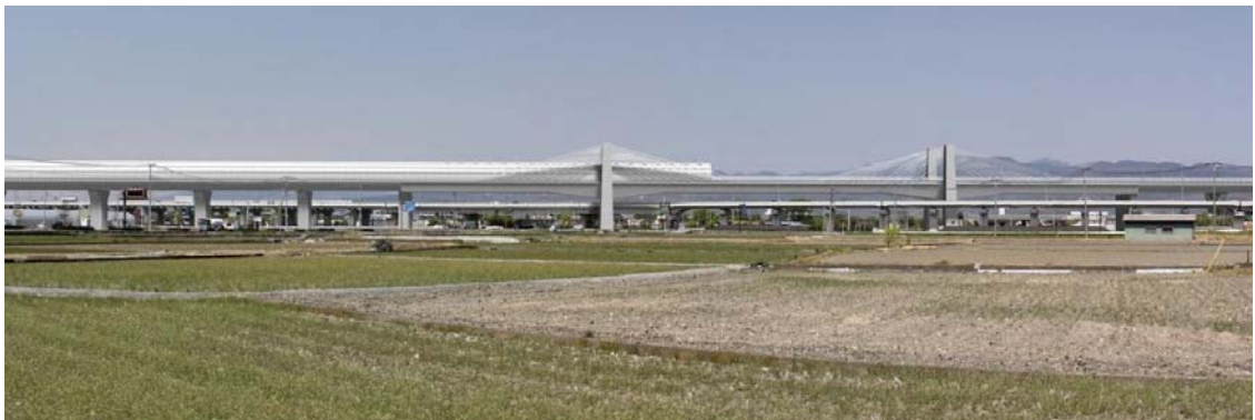
图 13-1-2-8 新山梨環状道路架道橋
