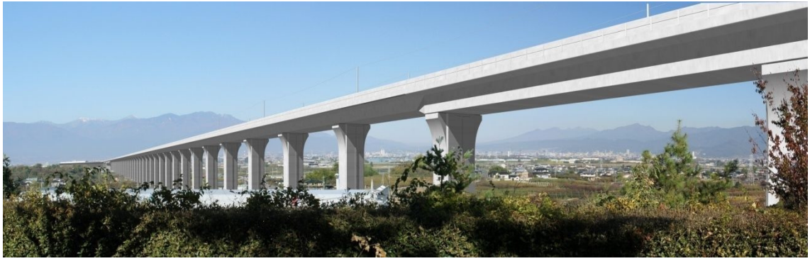
图 13-1-2-6 第1中央自動車道架道橋
