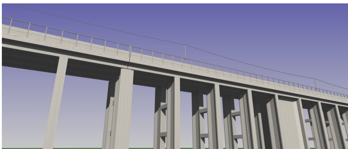
図 13-1-2-3 新形式高架橋（防音壁部）
