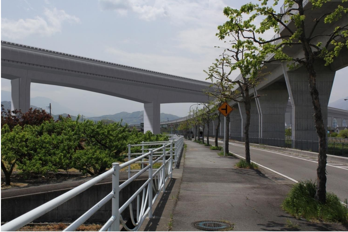
图 13-1-2-10 中部横断道架道橋
