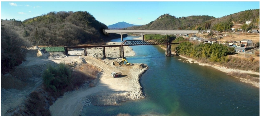
图 13-1-2-14 第2木曾川桥梁
