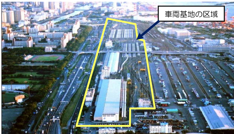
写真：東海道新幹線 「大井車両基地」 (東京都品川区)
