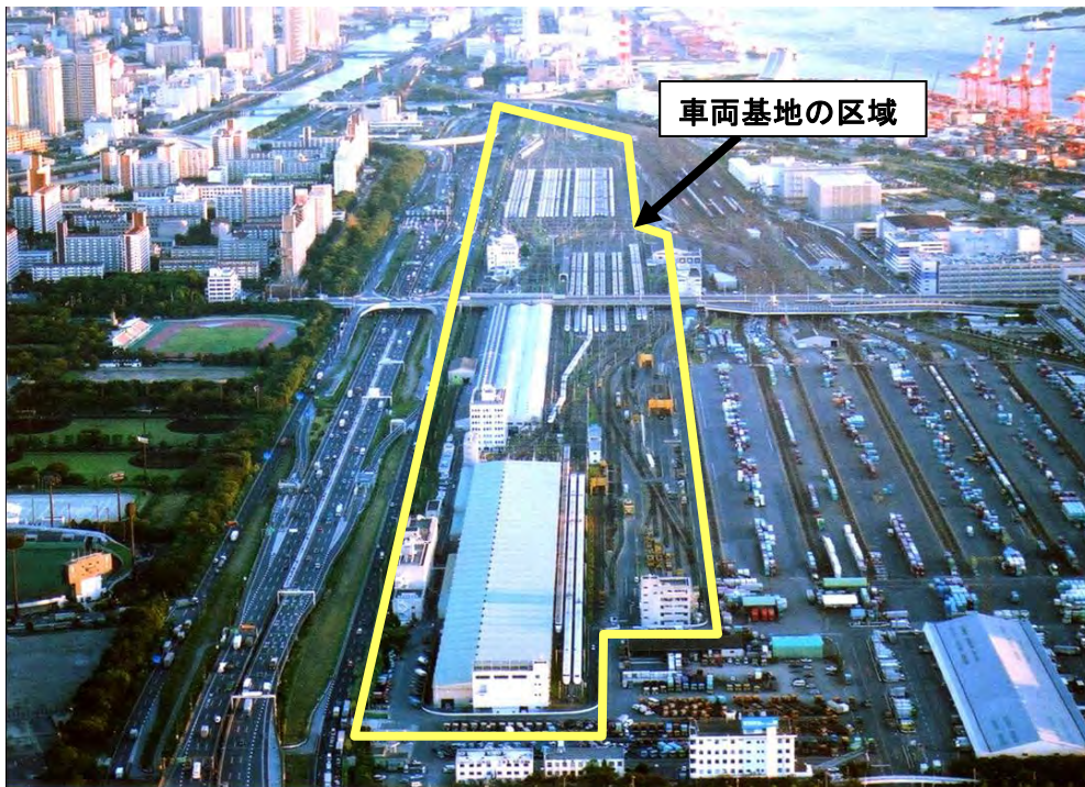
図 3-4-13 車両基地の例（東海道新幹線「大井車両基地」：東京都品川区）
