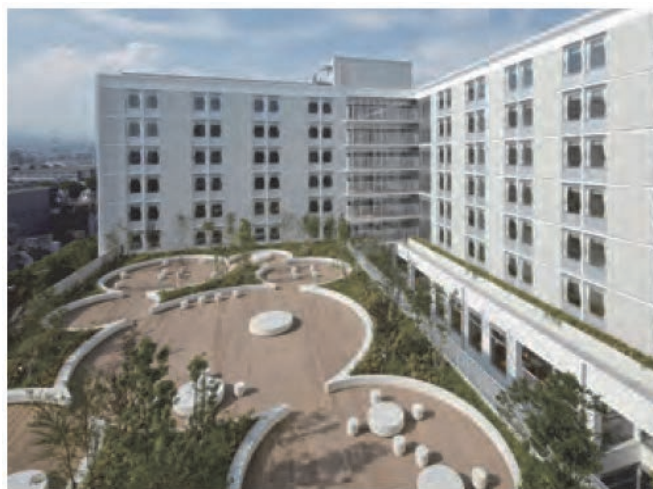
図 19-4-2-5 総合研修センター（屋上緑化）
