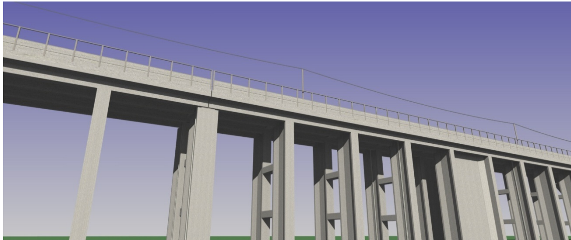
図 22-1-2-3 新形式高架橋（防音壁部）
