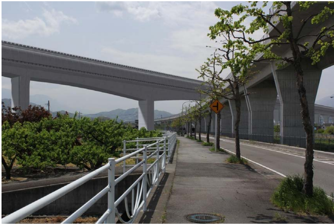
图 22-1-2-10 中部横断道架道橋
