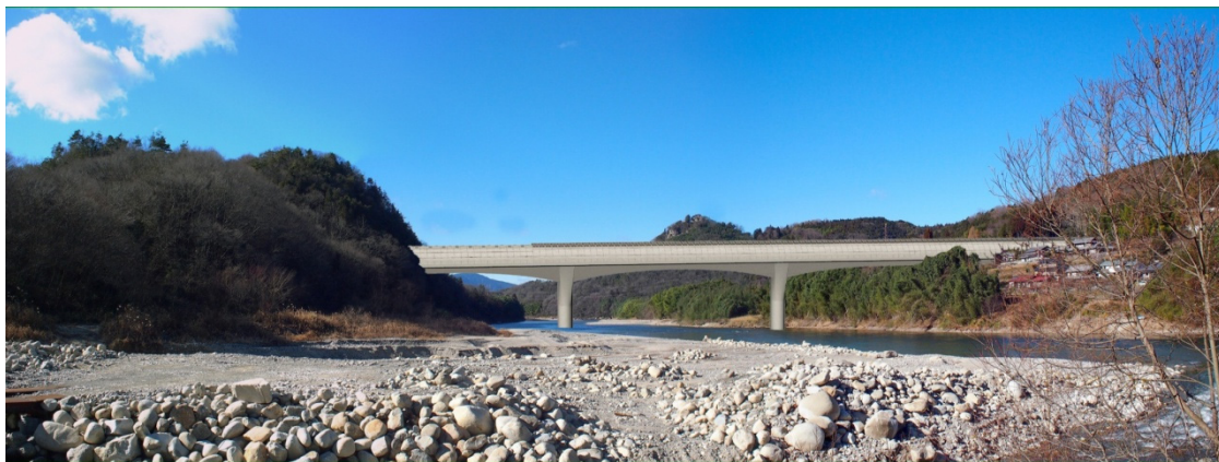
图 22-1-2-14 第 2 木曾川桥梁
