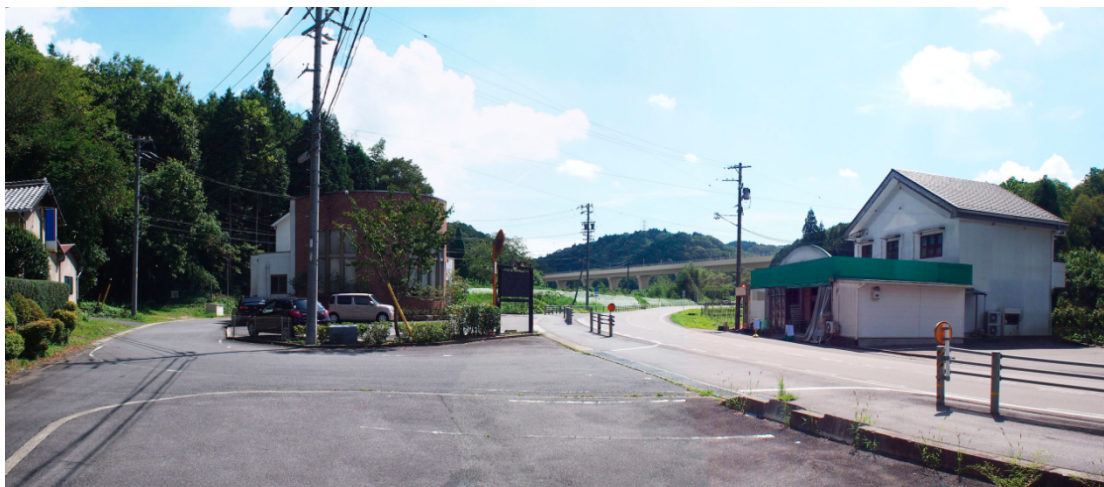
图 22-1-2-15 久々利高架桥
