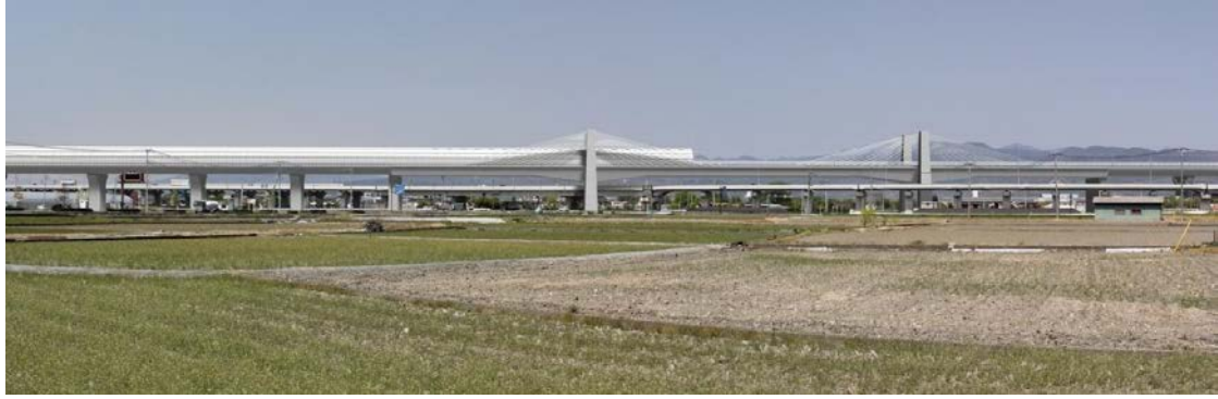
图 22-1-2-8 新山梨環状道路架道橋
