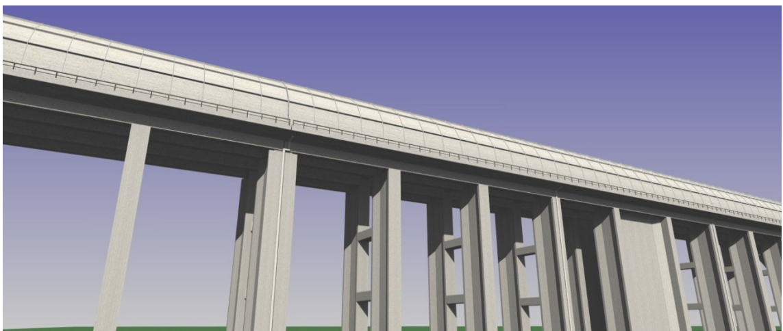
図 22-1-2-2 新形式高架橋（防音防災フード部）
