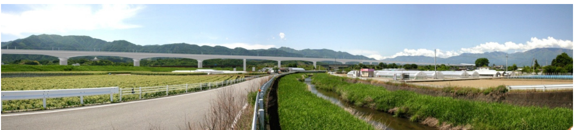
图 22-1-2-7 笛吹川・濁川桥梁及び第 2 中央自動車道架道橋
