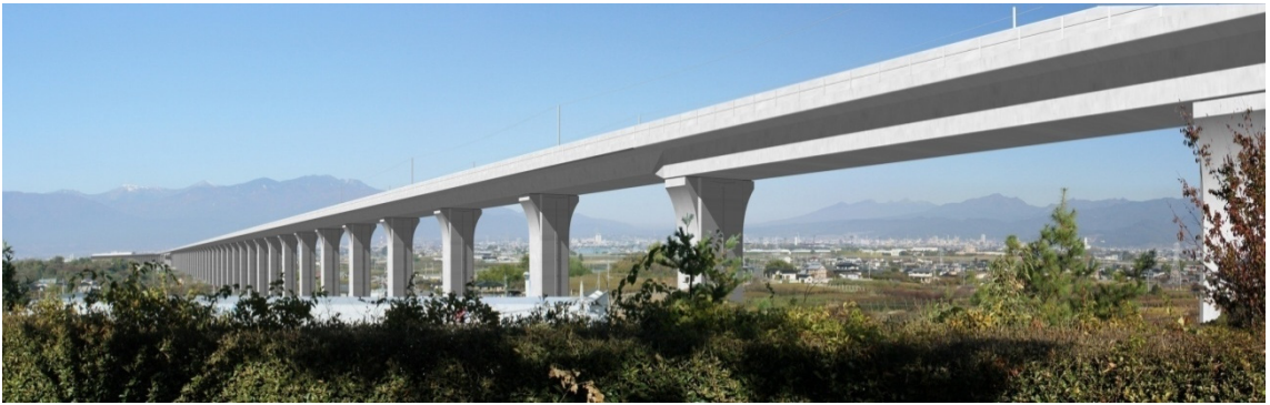
图 22-1-2-6 第 1 中央自動車道架道橋
