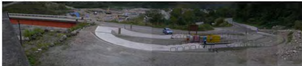
写真2 タイヤ洗浄装置（全景）
