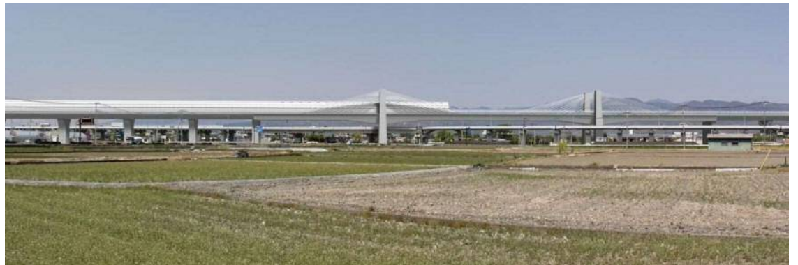
图 17-1-8 新山梨環状道路架道橋
