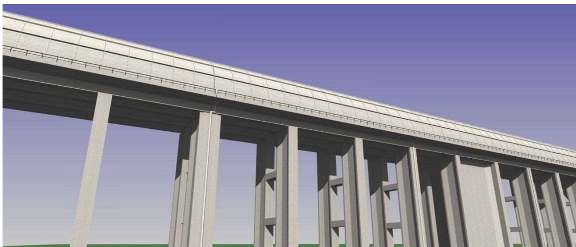
図 17-1-2 新形式高架橋（防音防災フード部）
