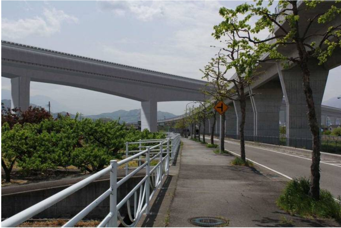
图 17-1-10 中部横断道架道橋
