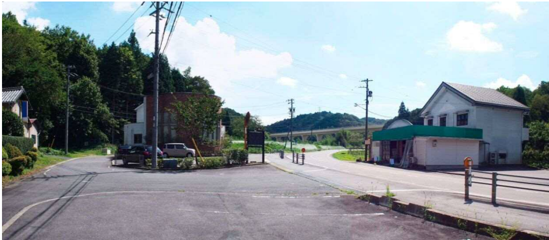
図 17-1-15 久々利高架橋
