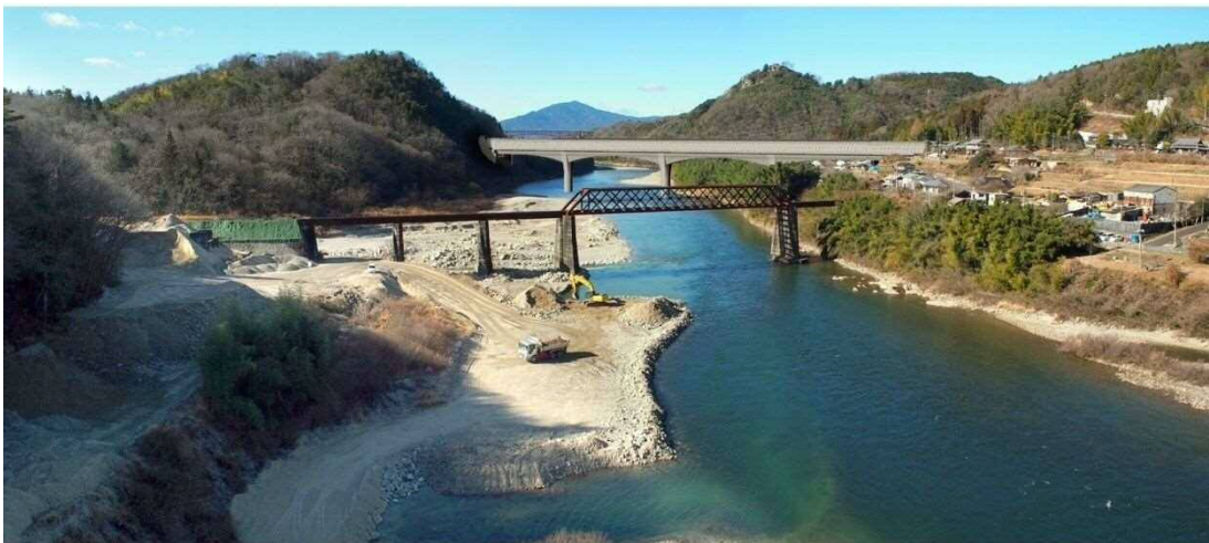
图 17-1-14 第 2 木曾川橋梁
