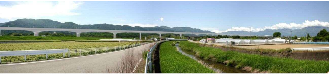
图 17-1-7 笛吹川・濁川橋梁及び第 2 中央自動車道架道橋
