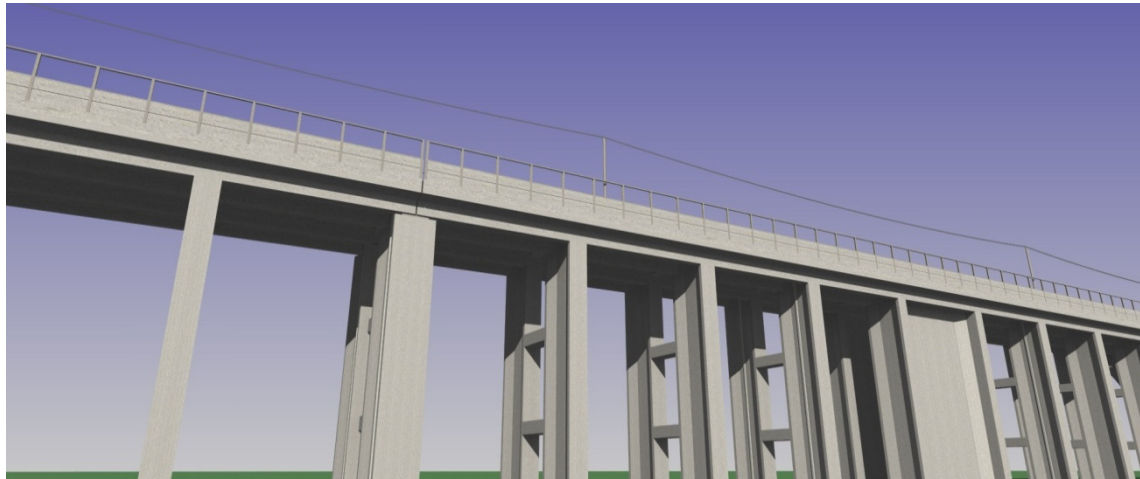
図 22-1-2-3 新形式高架橋（防音壁部）
