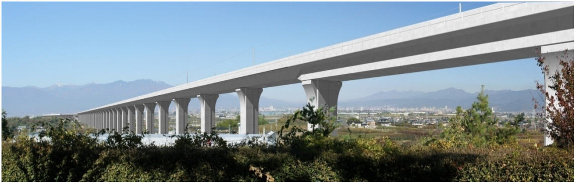
図 22-1-2-6 第1中央自動車道架道橋
