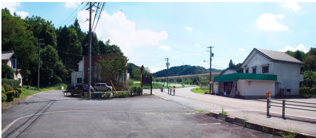
图 22-1-2-15 久々利高架桥
