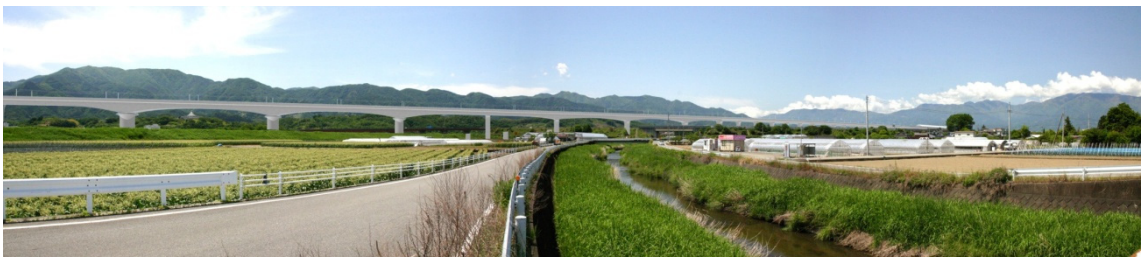
図 22-1-2-7 笛吹川・濁川橋梁及び第2中央自動車道架道橋
