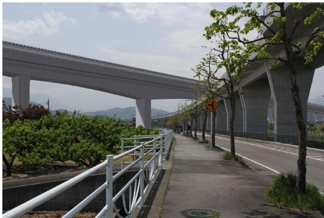
图 22-1-2-10 中部横断道架道橋
