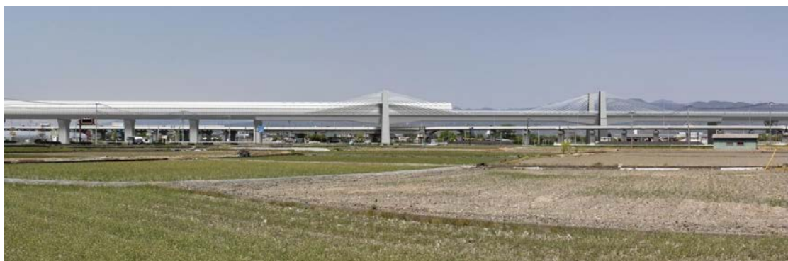
图 22-1-2-8 新山梨環状道路架道橋
