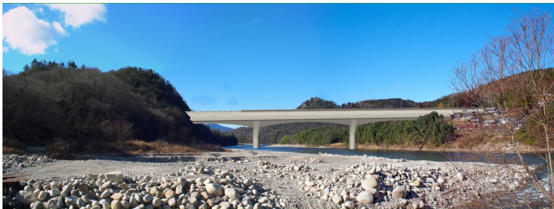
图 22-1-2-14 第2木曾川桥梁
