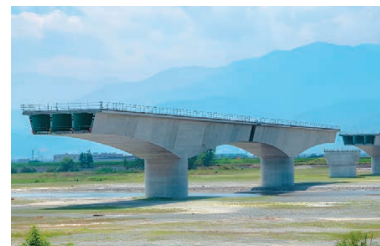
釜無川橋りょう 上部工
