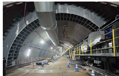
第一中京圏トンネル（名城工区） 本格的な掘進
