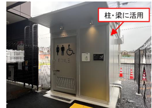
「東海道新幹線再生アルミ」の活用例（東武鉄道葛生駅のトイレの建材）
