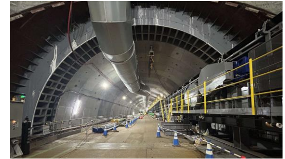
第一中京圏トンネル（名城工区） 本格的な掘進
