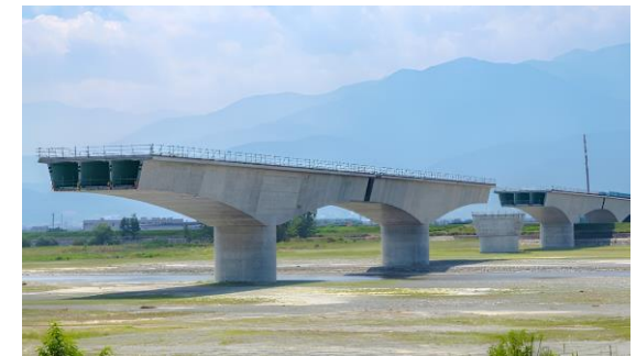
釜無川橋りょう 上部工
