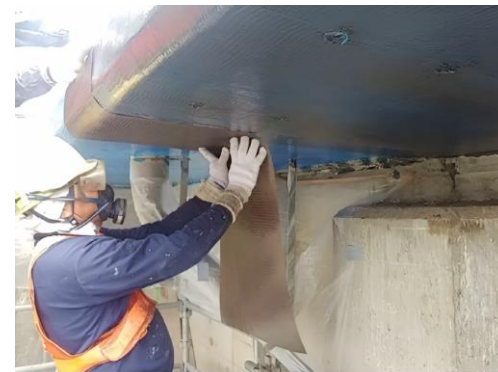
大規模改修工事
