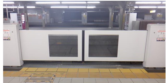
名古屋駅2番線ホームに設置する可動柵のイメージ (写真は5番線ホームに設置済の可動柵)
