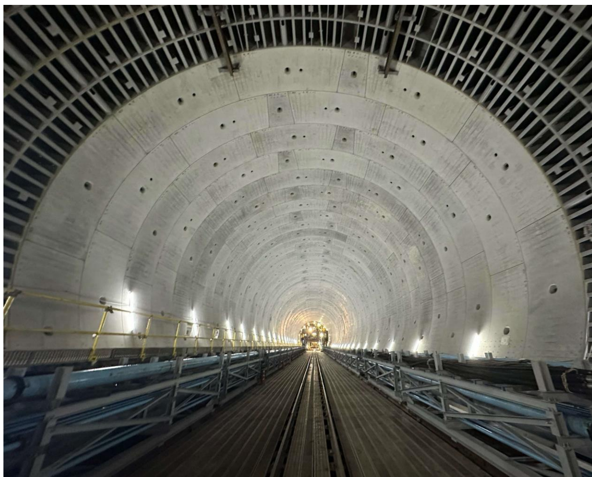
○東百合丘工区の坑内の状況（2023年9月29日撮影）
