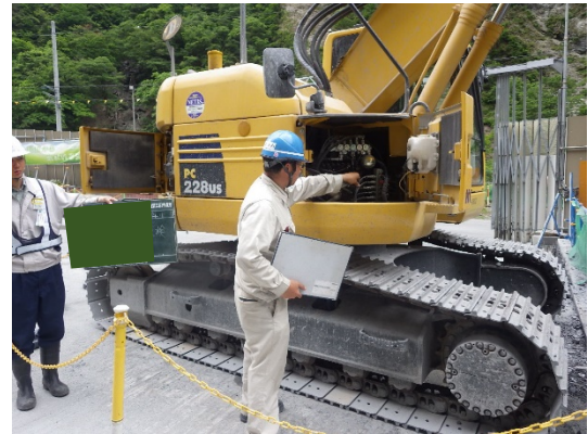
写真 6-2-2 建設機械の点検・整備
