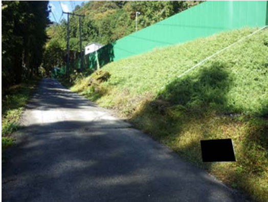
写真 6-2-19 のり面の緑化 (広河原非常口)
