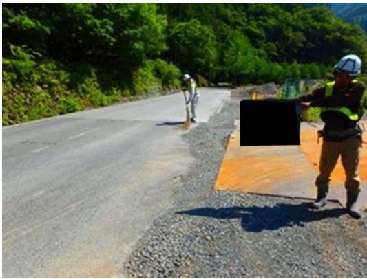
写真 6-4-3 清掃実施状況 (塩島地区(南)発生土仮置き場)
