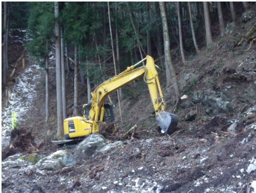
重機作業による整地作業
