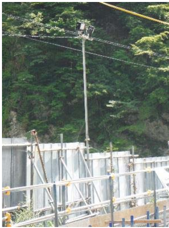
写真 6-2-17 LED 照明（点灯前） （早川非常口）
