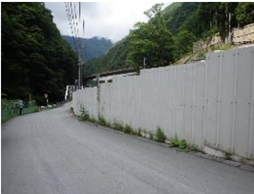
写真 6-2-5 仮囲いの設置 (早川非常口)
