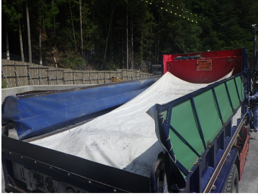
写真 6-4-7 運搬時の浸透防止シート設置状況
