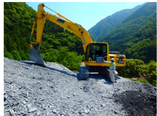
写真 6-4-6 建設機械の点検・整備
