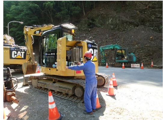
写真 6-1-2 建設機械の点検・整備
