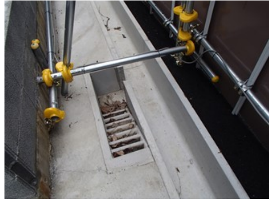
写真 6-1-12(1) 小動物が脱出可能な側溝
