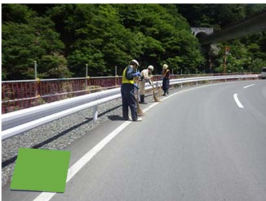
写真 6-1-5(1) 工事現場の清掃
