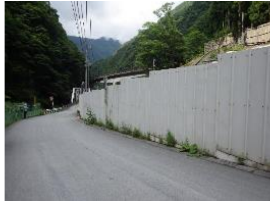
写真4-1-4 仮囲い設置状況（早川非常口）
