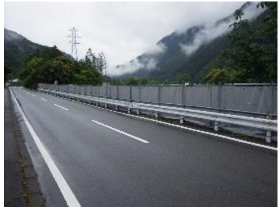
写真4-2-4 仮囲い（防音シート）設置状況
