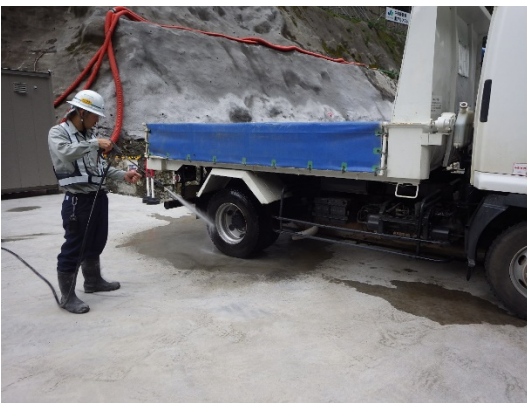
写真4-1-5 タイヤ洗浄状況（一例）
