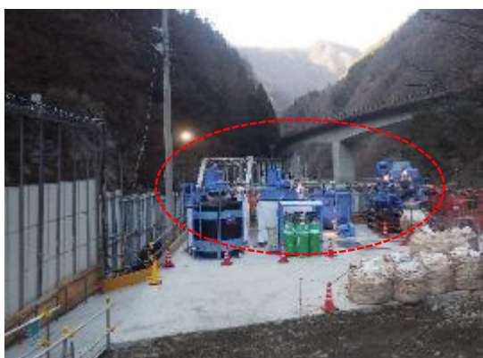
写真4-1-7 濁水処理設備の状況（早川非常口）
