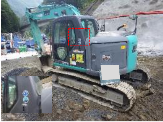
写真4-1-1 排出ガス対策型、低騒音型 建設機械の採用（一例）
