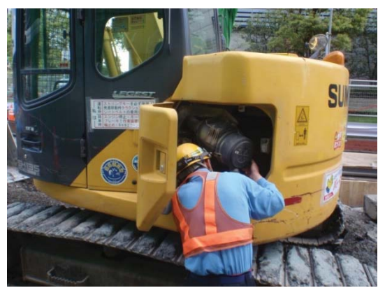
写真-2 建設機械の点検及び整備の状況
