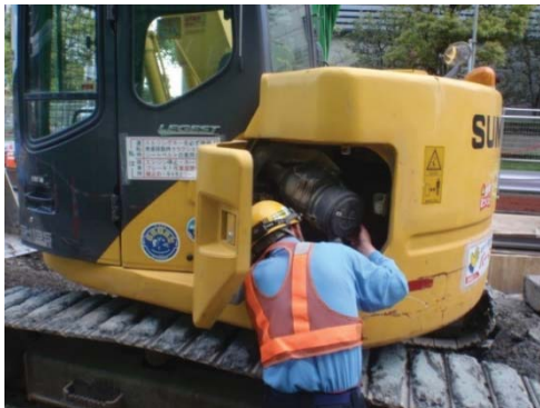
写真-1 建設機械の点検及び整備の状況
