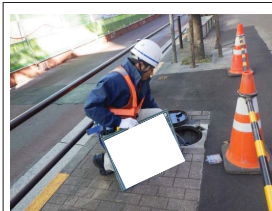
写真-13 地下水の監視状況（品川駅）
