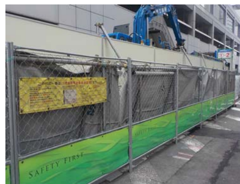
写真-12 仮囲い・防音シート等の設置による遮音対策の状況
