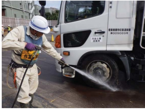
写真-10 タイヤの洗浄の状況
