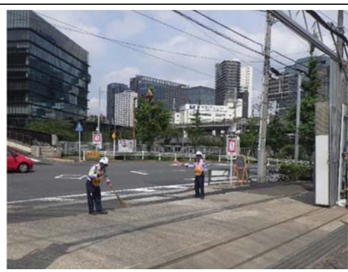
写真-9 車両の出入り口、周辺道路の清掃の状況
