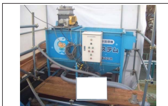
写真-15 工事排水の処理状況
