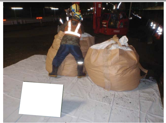
写真-2 発生土の管理状況
