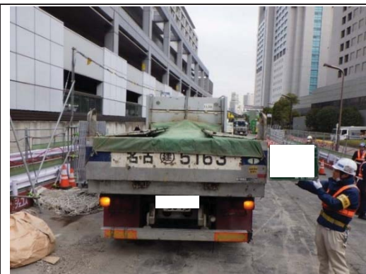
写真-8 荷台への防じんシート敷設の状況
