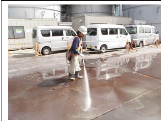
写真-6 工事現場の清掃、散水の状況
