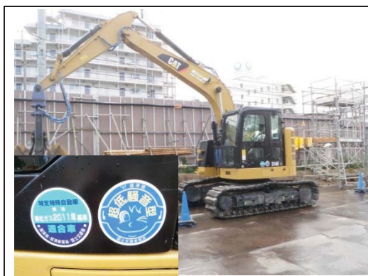
写真-11 低騒音型建設機械の使用の状況
