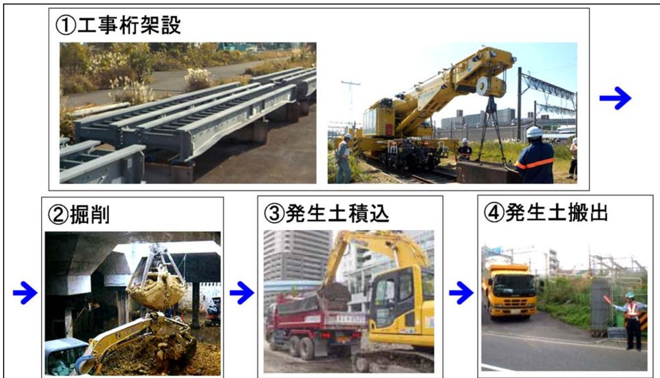
図 2-3 (6) 掘削工（鉄道部）の施工手順（写真は類似工事の例）
