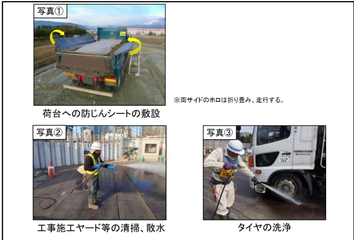
図 3-4 資材及び機械の運搬による影響を低減するための環境保全措置
