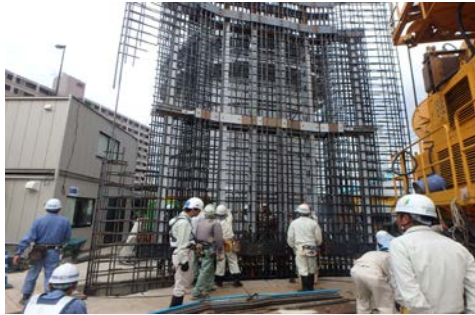
図 2-3(2) 地中連続壁工の施工手順 (写真は類似工事の例)
