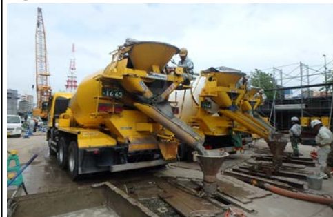
図 2-3(2) 地中連続壁工の施工手順 (写真は類似工事の例)
