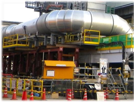
坑内換気設備
