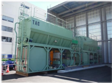
掘削用プラント設備
