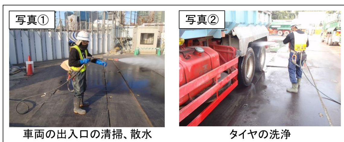
図 3-4 資材及び機械の運搬に用いる車両の運行による影響を低減するための環境保全措置
