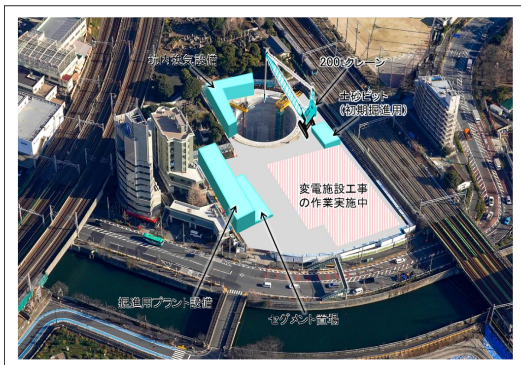
図 2-9 地上設備の設置位置
