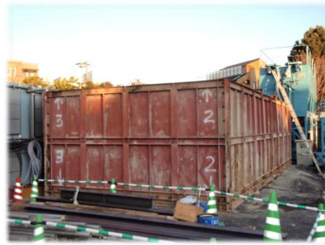
土砂ピット(初期掘進用)
